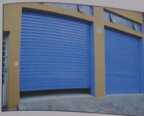
Foto 04: Entrada do galpão
