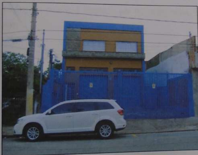
Foto 01: Vista da fachada
