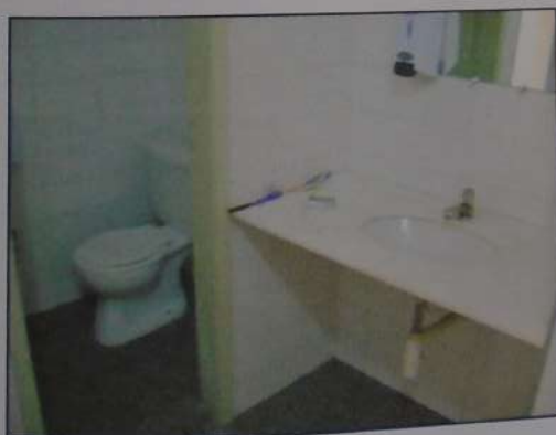
Foto 20: Banheiro do vestiário 01
