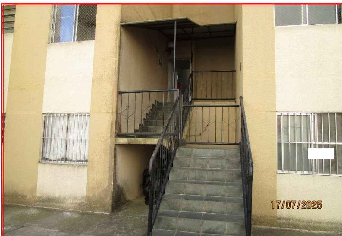
Foto nº 18: Vista da escada de acesso ao Bloco 02 “São Diego”.
