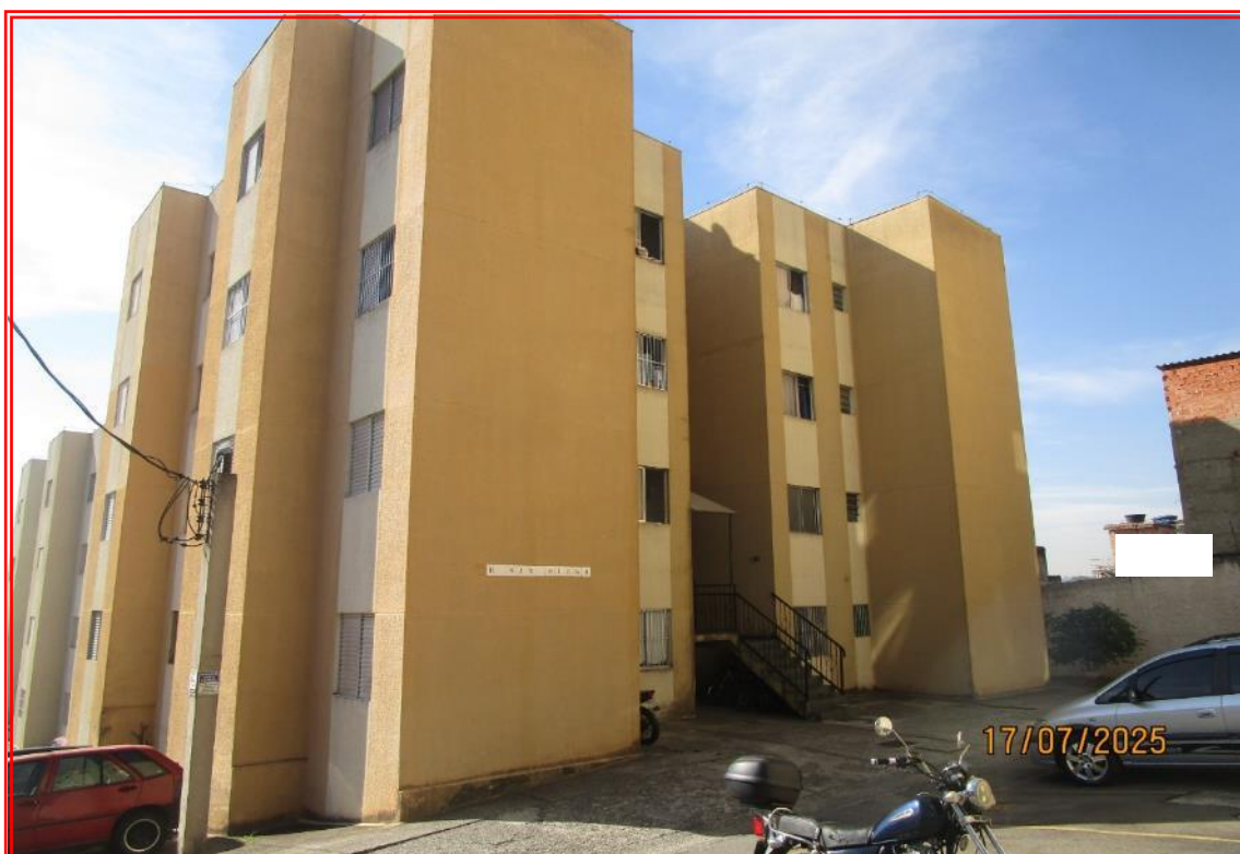
Foto nº 17: Vista parcial do Bloco 02 “São Diego”, onde se localiza o apartamento similar vistoriado.
