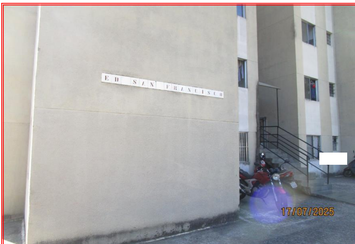
Foto nº 13: Vista parcial do Bloco 04 “São Francisco”, onde se localiza o imóvel avaliando.
