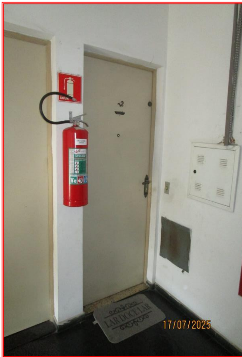
Foto nº 16: Vista do hall de circulação, com detalhe para a porta de entrada do apartamento nº 52.
