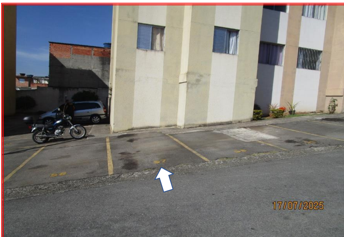
Foto nº 11: Vista geral da vaga de garagem descoberta “57” de uso exclusivo do apartamento nº 52 do Bloco 04, Edifício “São Francisco”.
