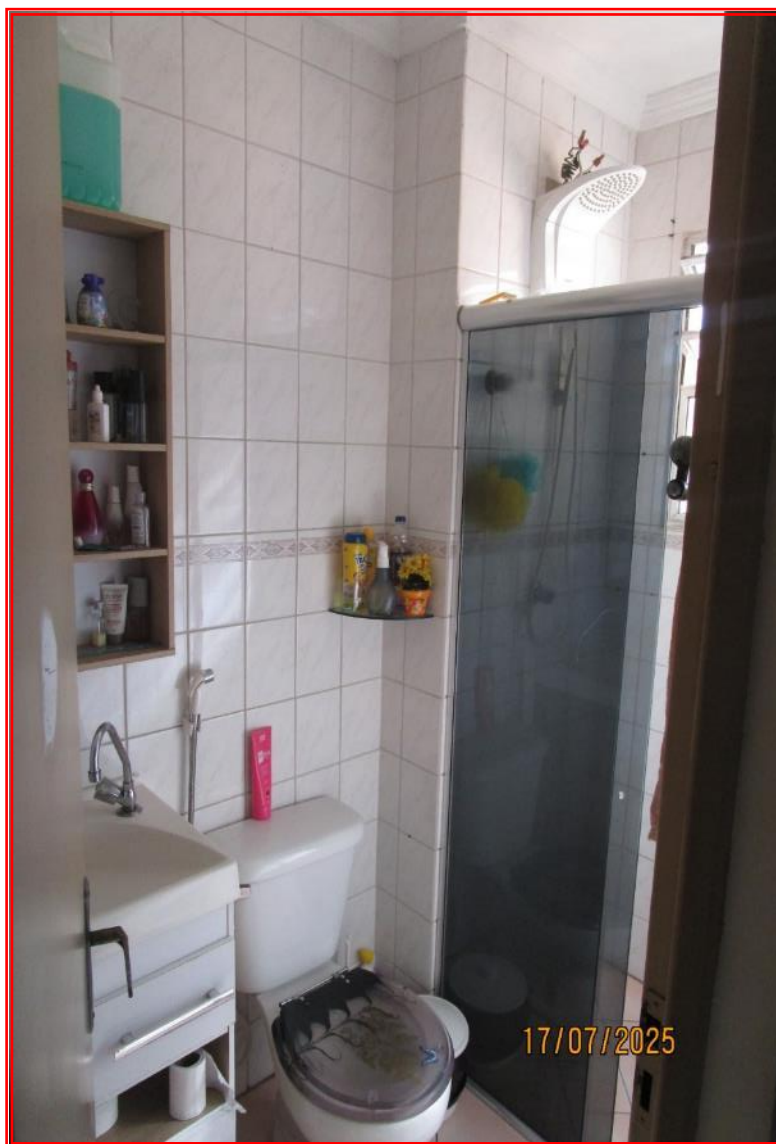
Foto nº 25: Vista parcial do banheiro ( unidade similar vistoriada ).
