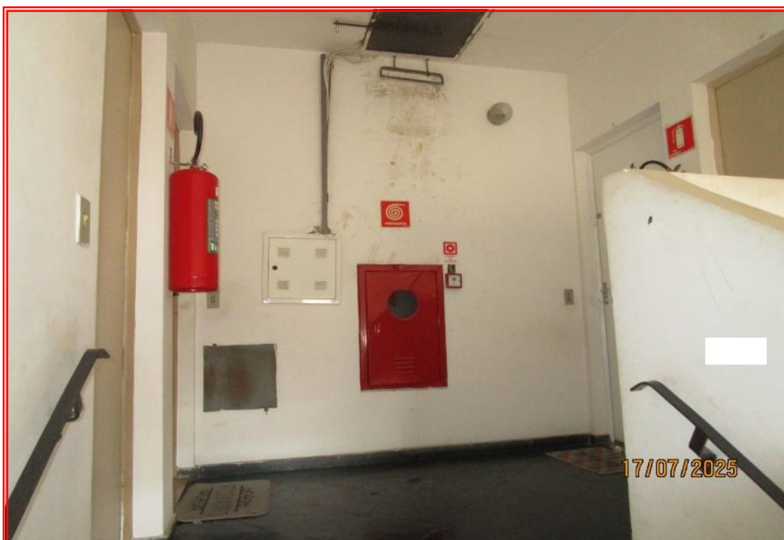
Foto nº 15: Vista do hall de circulação do 5º pavimento, onde se localiza o apartamento avaliando.
