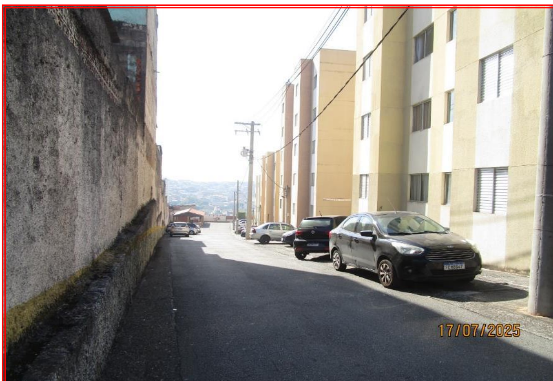
Foto nº 08: Vista geral da alameda de acesso aos blocos de apartamentos.
