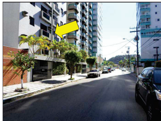
Foto 2 – Av. Marechal Hermes sentido Av. Mal. Mallet na quadra do edifício do apartamento avaliado.
