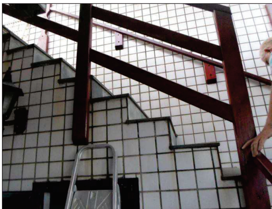
Foto 18 Escada coberta de acesso ao 2º pavimento superior
