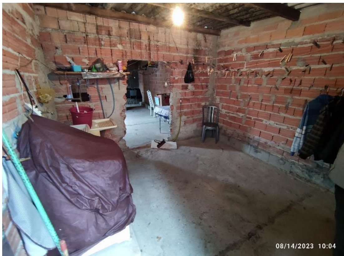
Foto 15 – Vista da obra do terceiro pavimento.
