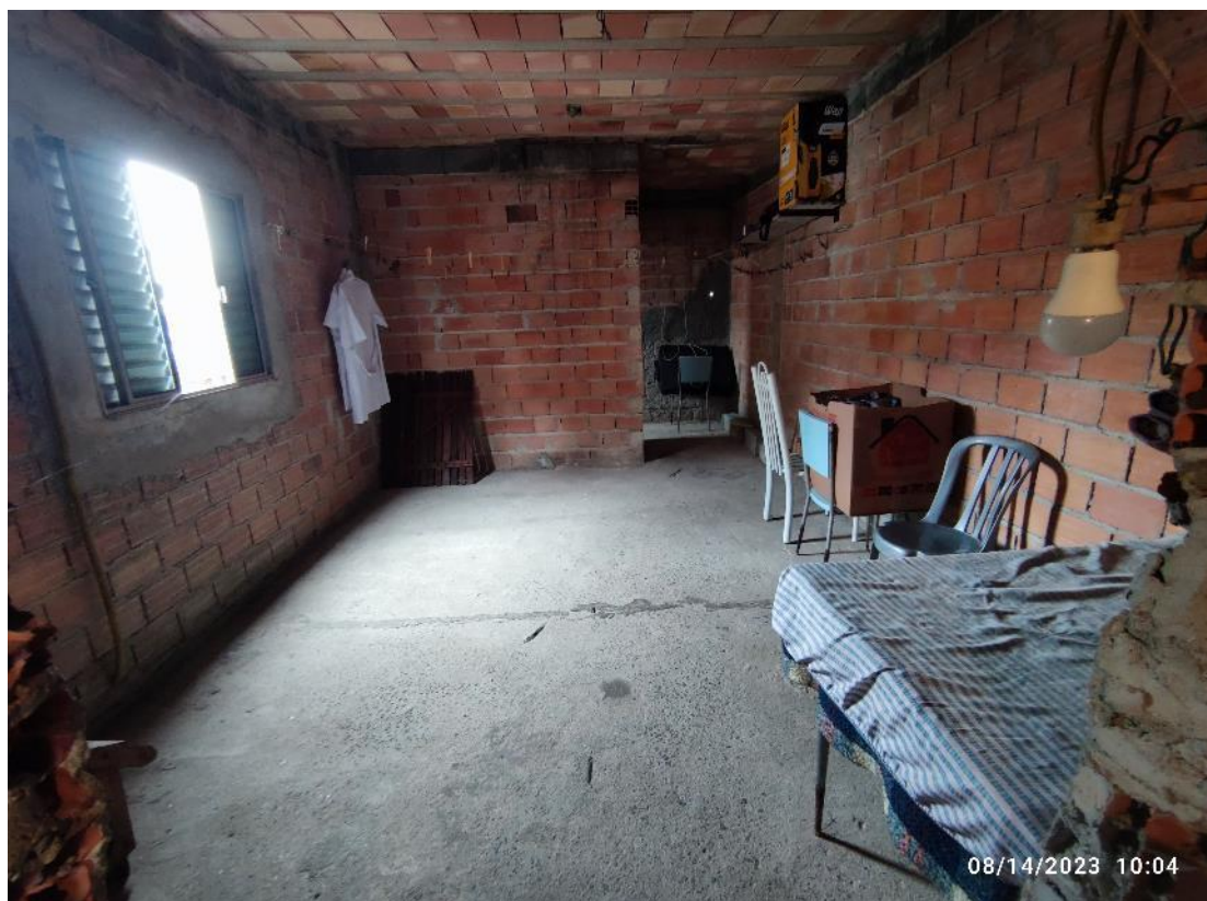
Foto 16 – Outra vista da obra do terceiro pavimento.
