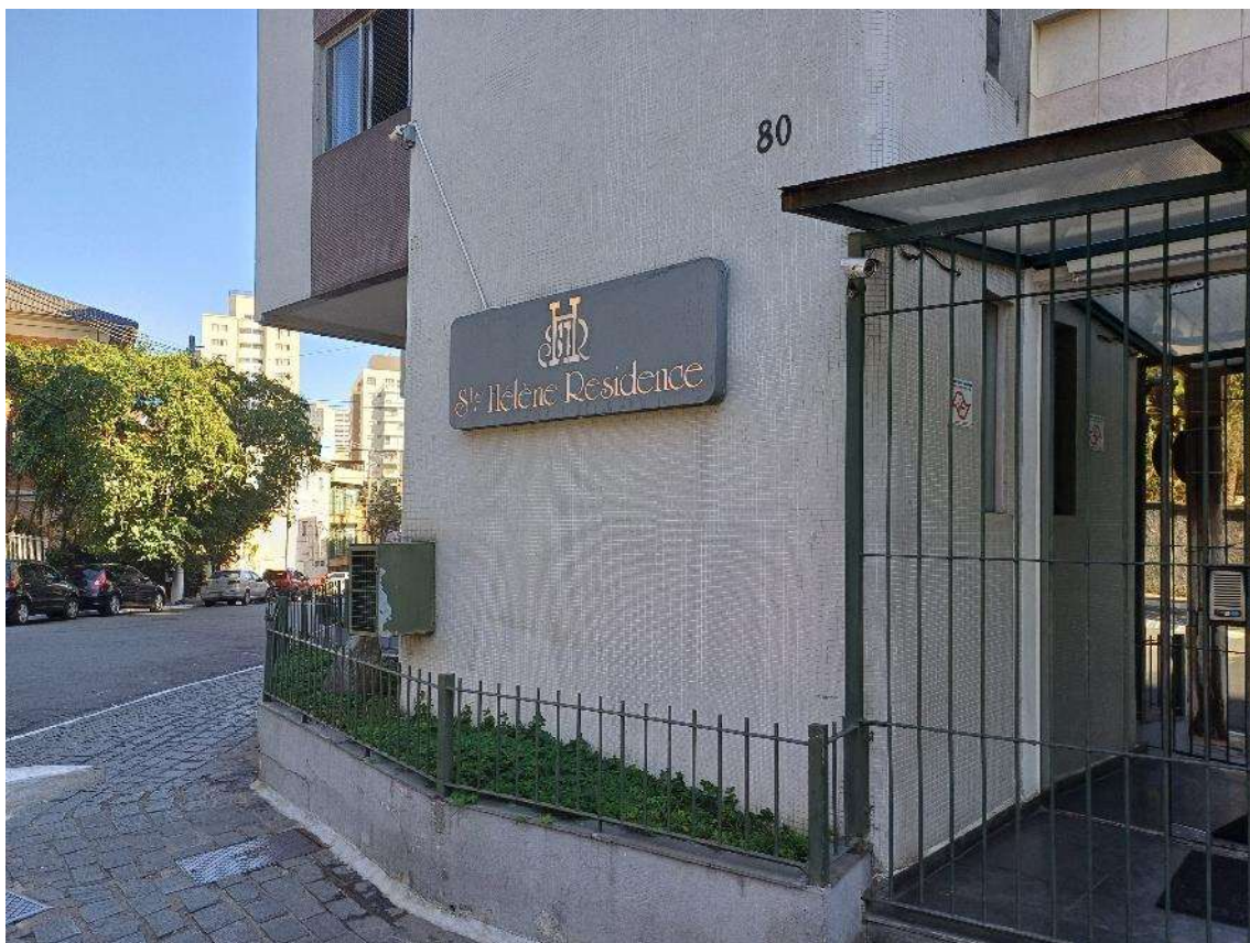
Condomínio Edifício Santa Helena – Entrada social
