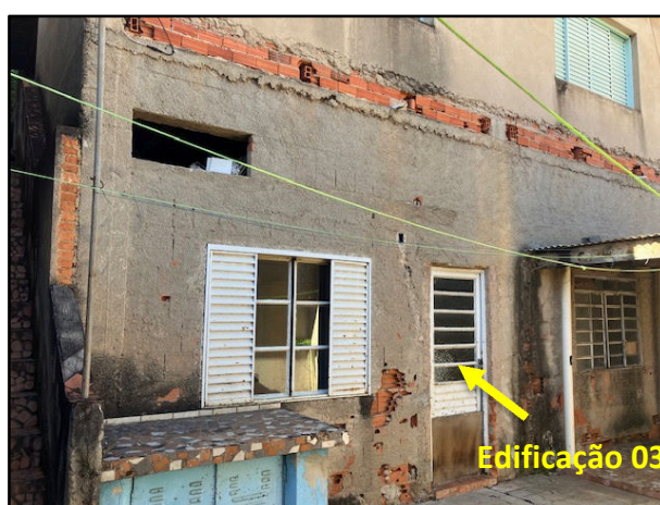
Figura 19- Vista frontal da edificação 03
