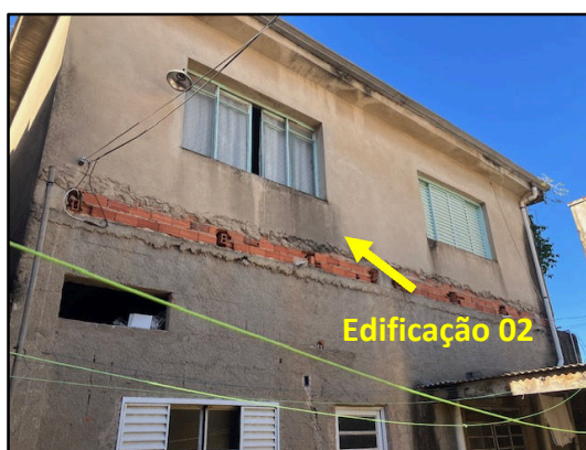
Figura 13- Vista frontal da edificação 02 (casa principal)
