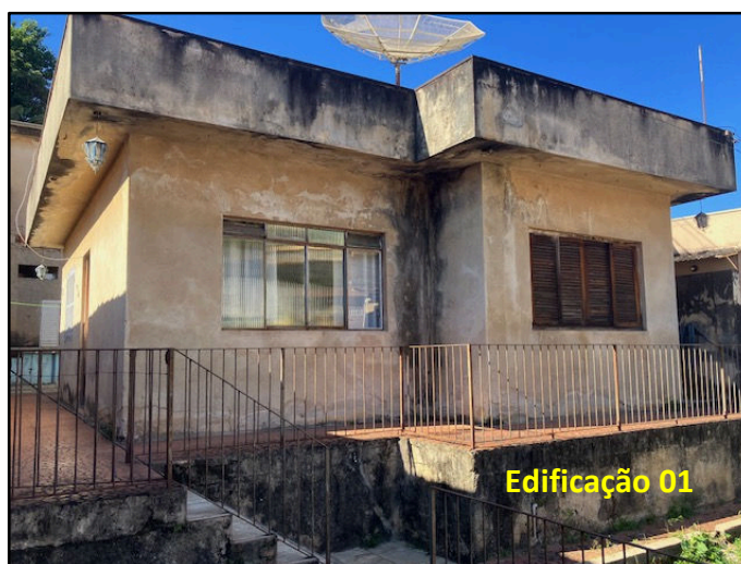
Figura 8- Vista frontal da edificação 01 (janelas da sala e quarto)
