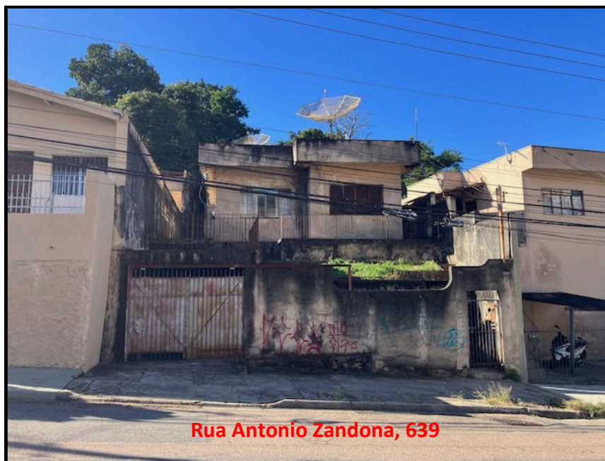
Figura 6- Fachada do Imóvel Avaliando
