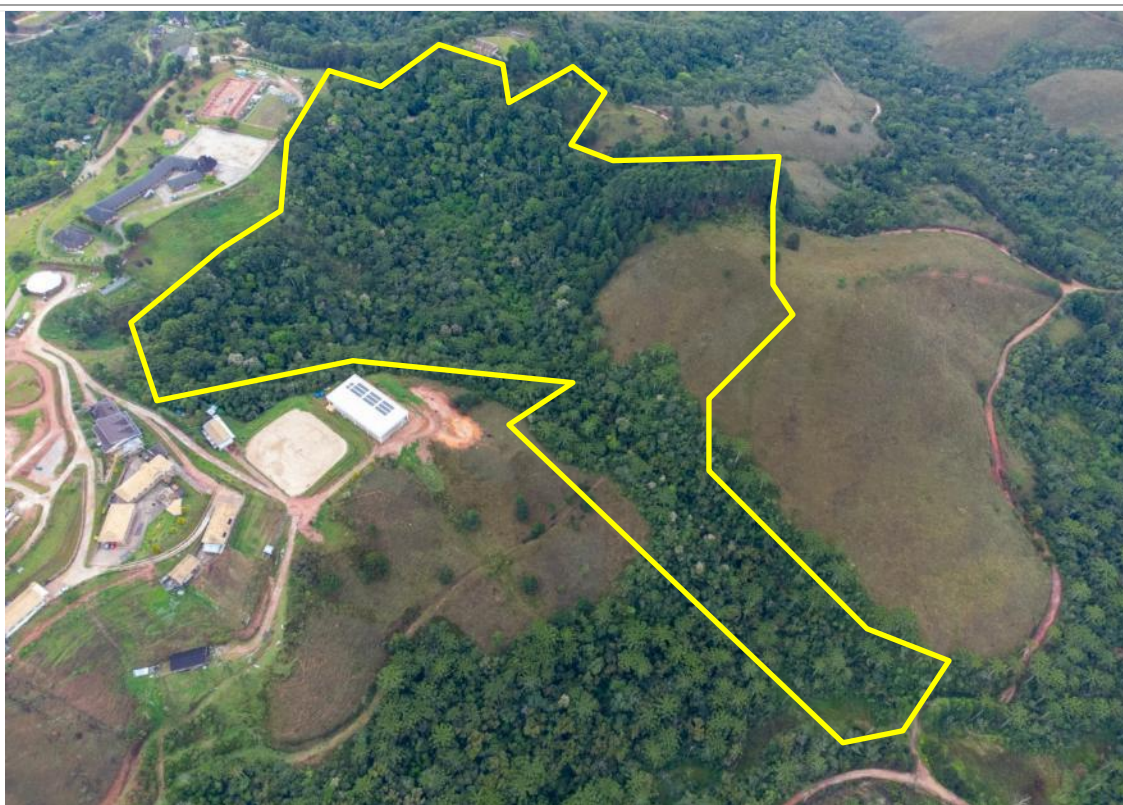
Foto 11. Imagem aérea (drone) disponibilizada à signatária, contendo a delimitação aproximada da área correspondente à Matrícula nº 18.002.
