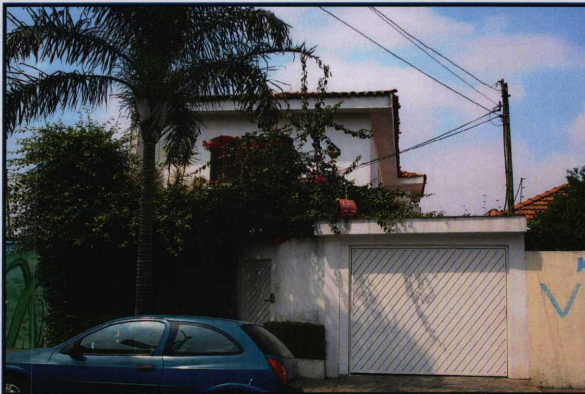
FOTO nº 03 Vista da fachada frontal do imóvel avaliando.
