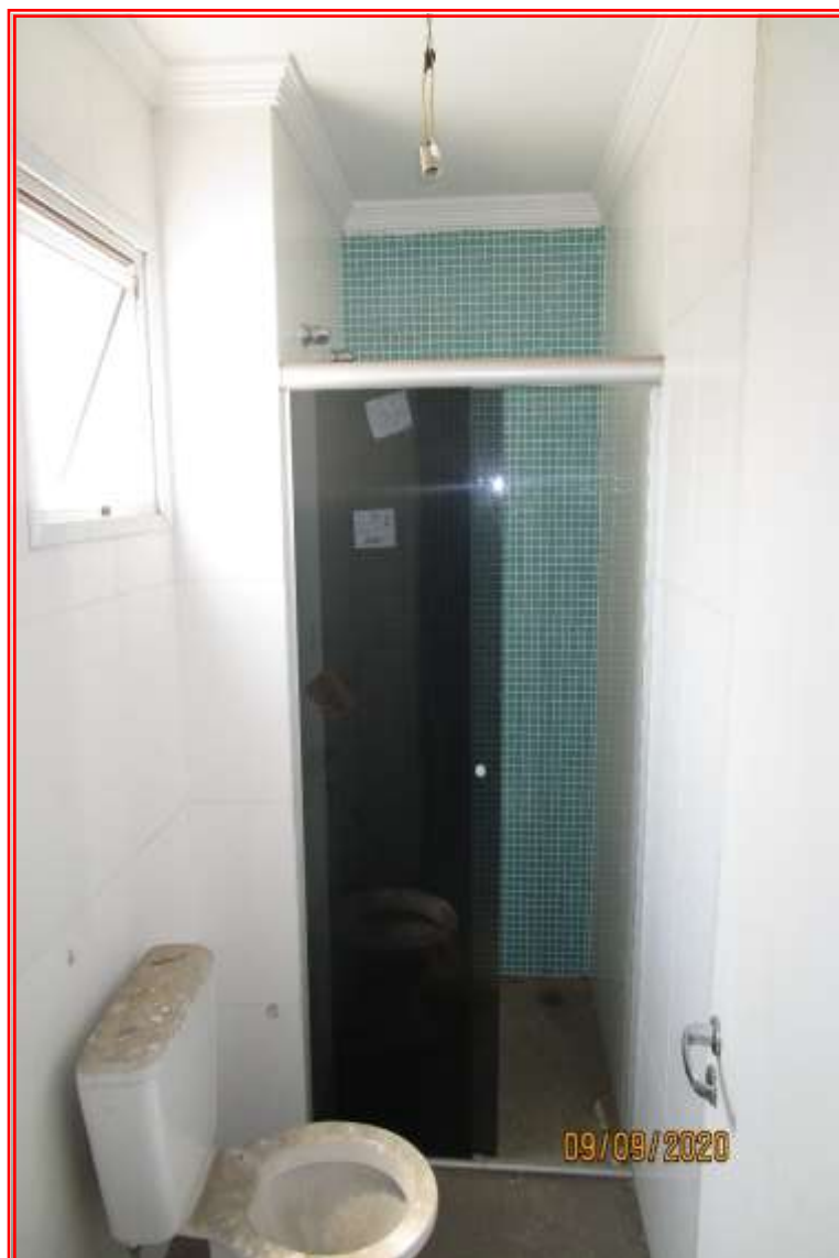
Foto nº 32: Aspecto parcial do banheiro da suíte 03.
