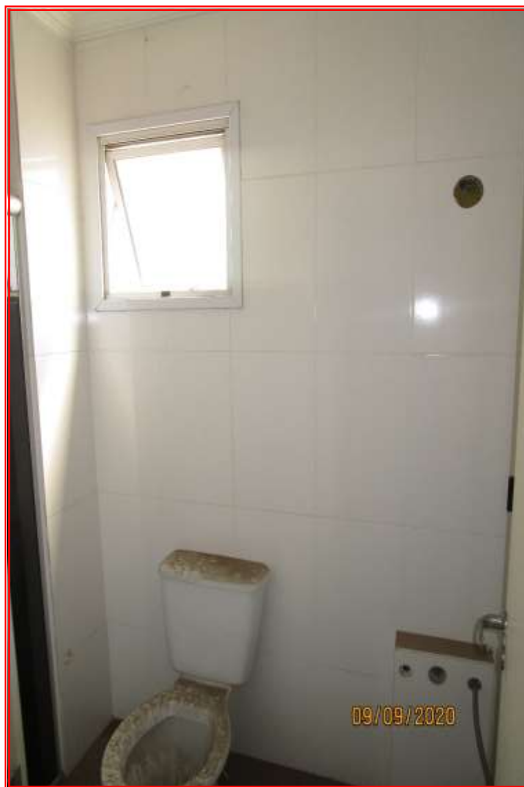
Foto nº 24: Vista parcial do banheiro da suíte 01.
