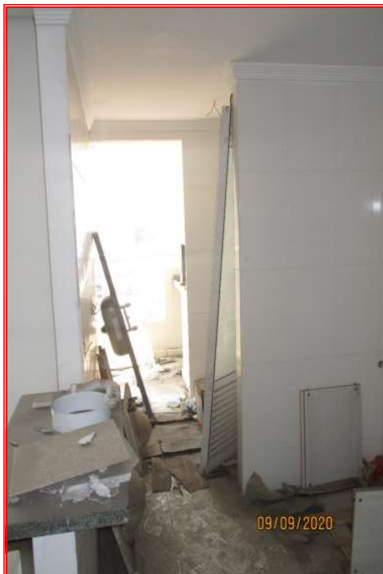
Foto nº 20: Vista parcial da cozinha e área de serviço.
