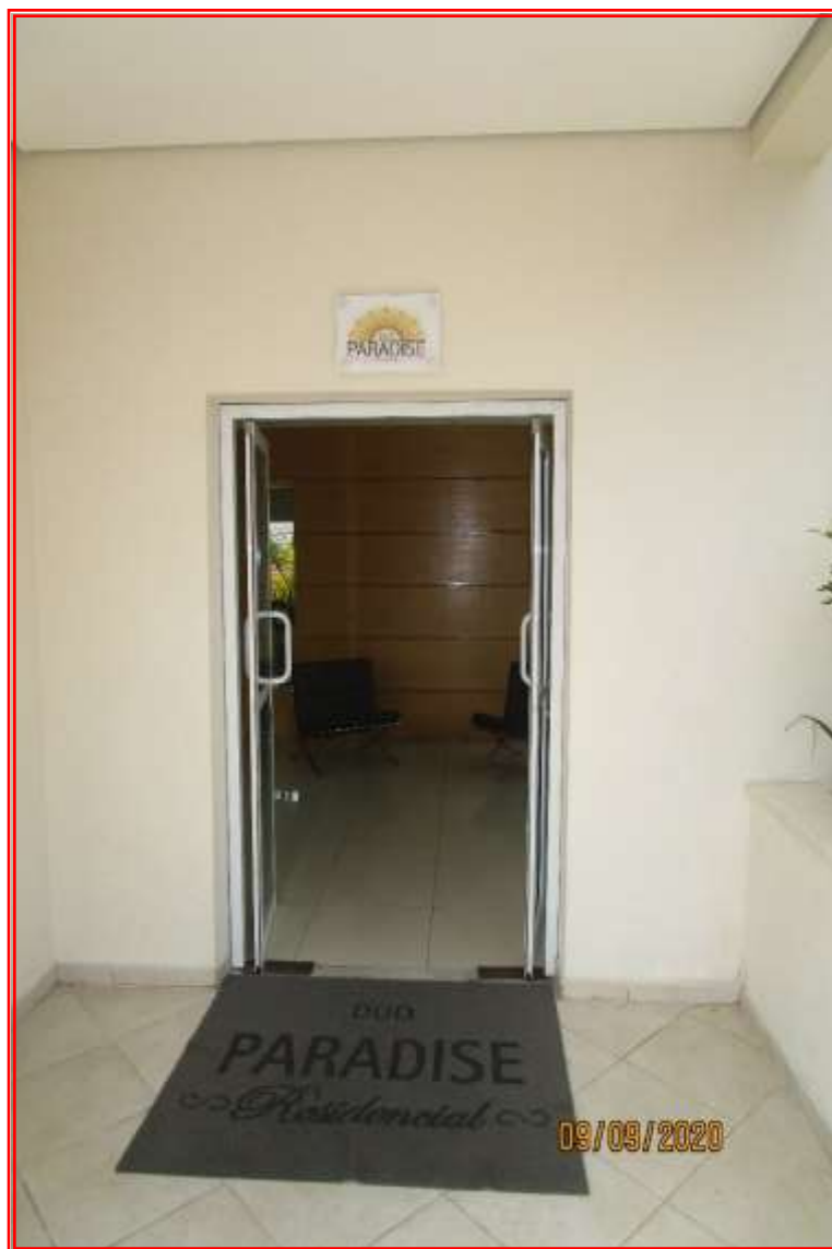
Foto nº 04: Vista parcial do acesso ao Hall principal do Condomínio Paradise Residencial.
