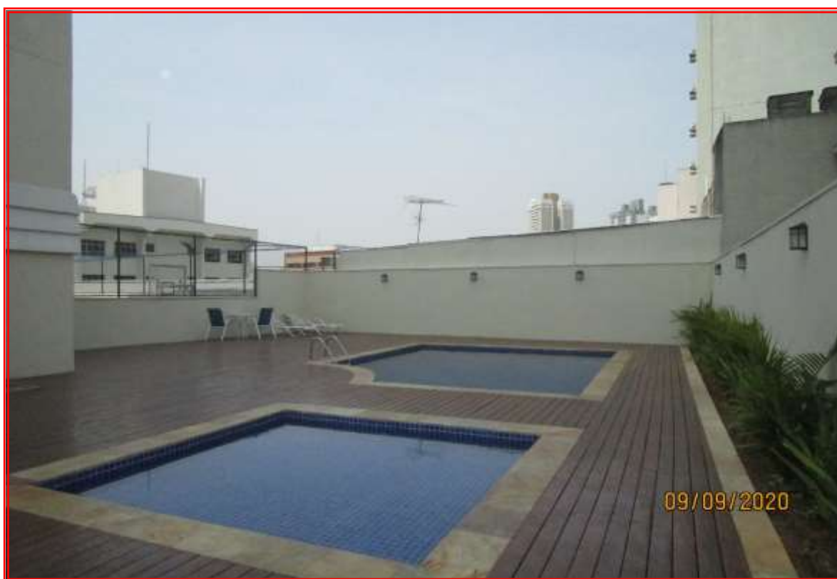
Foto nº 13: Vista geral da área das piscinas.
