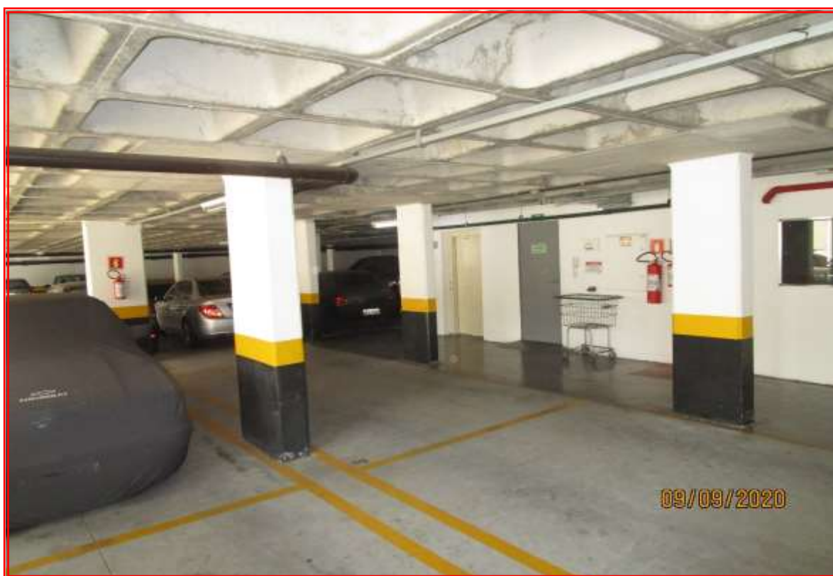
Foto nº 33: Vista parcial da garagem do subsolo.
