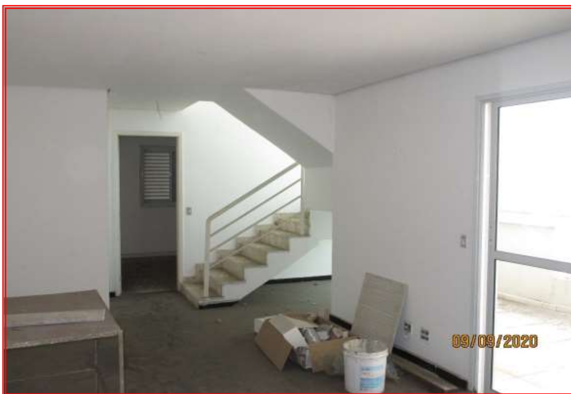
Foto nº 19: Vista parcial da sala de estar e jantar (integrada). Detalhe para remanescentes de materiais.
