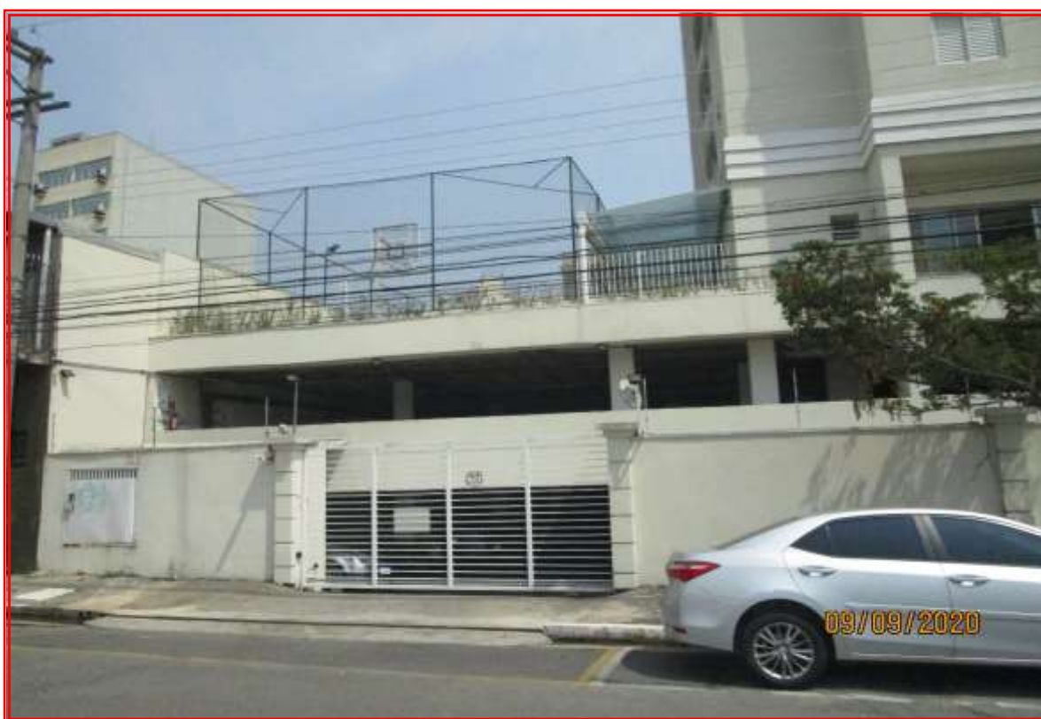
Foto nº 03: Vista geral do acesso pela Rua Avelino Lopes ao subsolo destinado às vagas de garagem.
