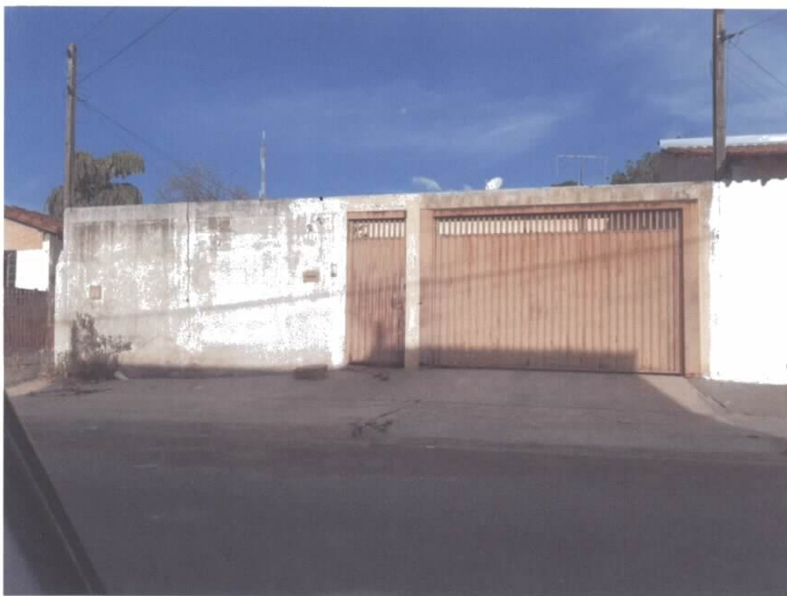
Vista do Imóvel Avaliando
