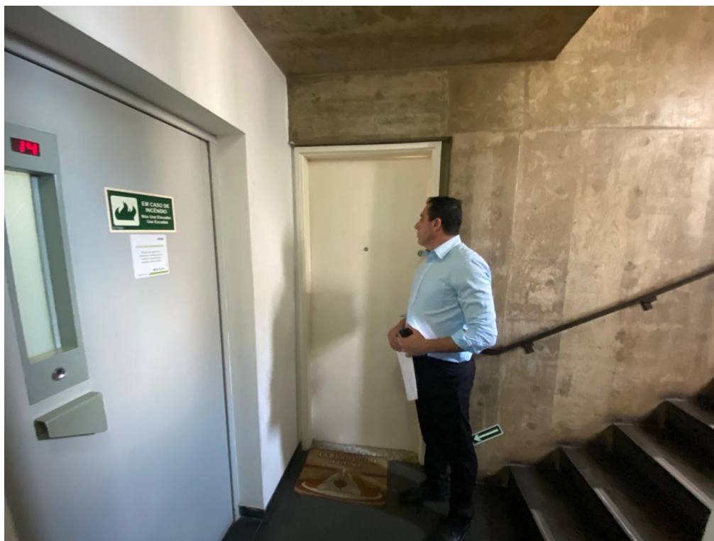
OUTRA VISTA DA ÁREA COMUM DE ACESSO AOS PAVIMENTOS.
