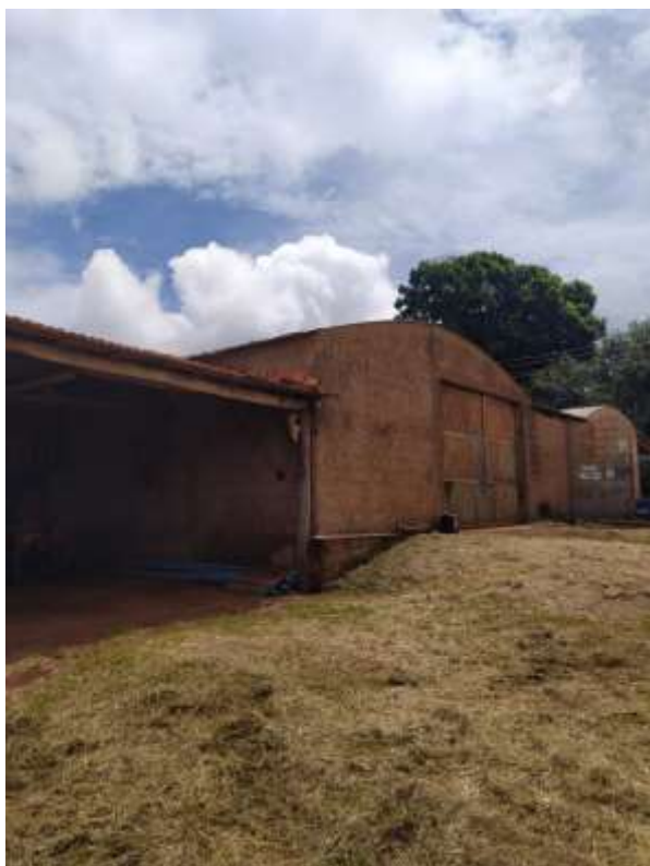
Figura 24- Barracão de Implementos 2 (A= 347,70 m 2 )
