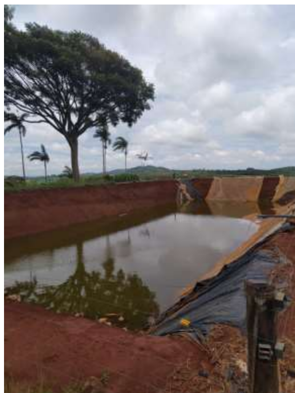
Figura 29- AÇUDE 2 ( A= 1354,50 \text{ m}^2 )
