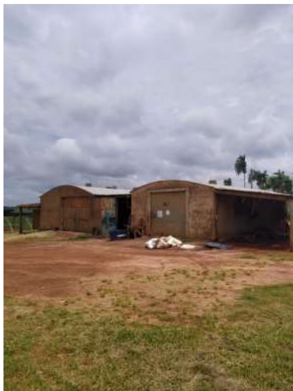
Figura 25- Barracão de Implementos 2 (A= 347,70 m 2 )
