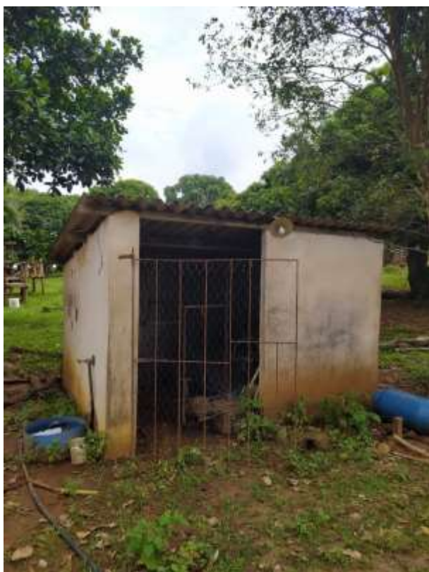
Figura 8 - CÔMODO EDIFICADO 2 (A= 11,00 m 2 )
