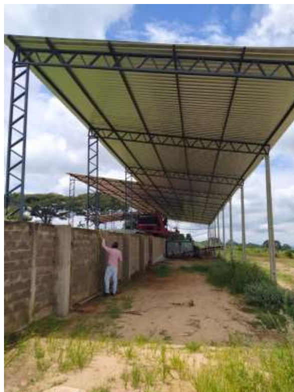
Figura 21- Barracão de Implementos 1 ( A= 920,00 \text{ m}^2 )
