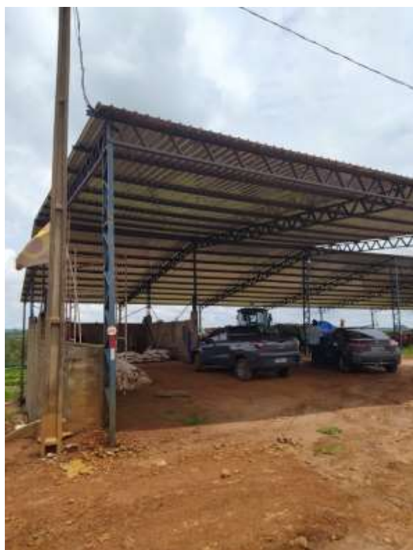
Figura 20 - Barracão de Implementos 1 ( A= 920,00 \text{ m}^2 )
