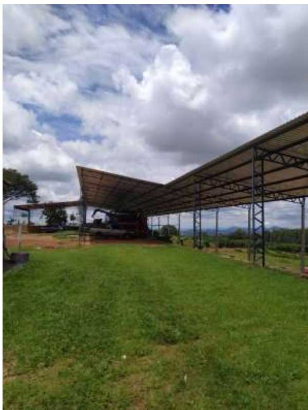
Figura 22- Barracão de Implementos 1 ( A= 920,00 \text{ m}^2 )
