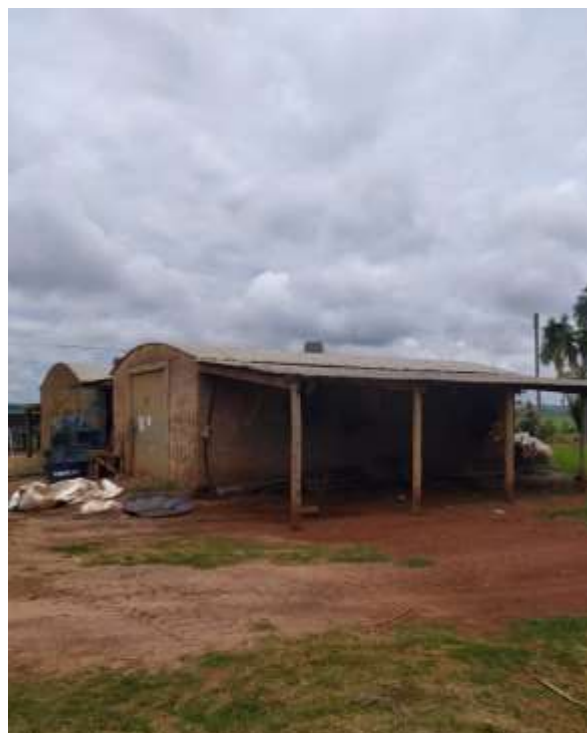
Figura 23- Barracão de Implementos 2 ( A= 347,70 \text{ m}^2 )
