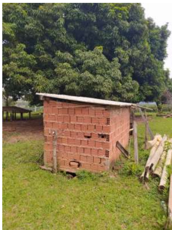
Figura 9- CÔMODO EDIFICADO 1 (A= 7,50 m 2 )
