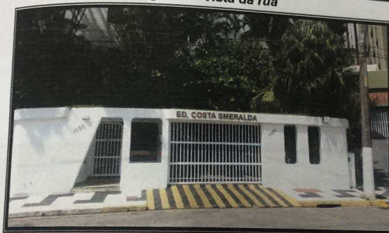
Figura 4 - Entrada do Condomínio
