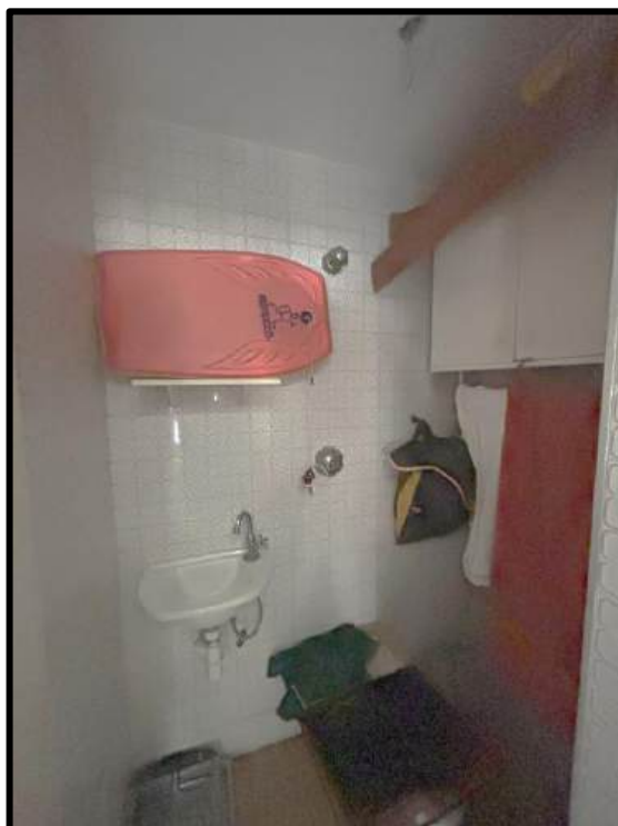
Foto 105: Banheiro de serviço
