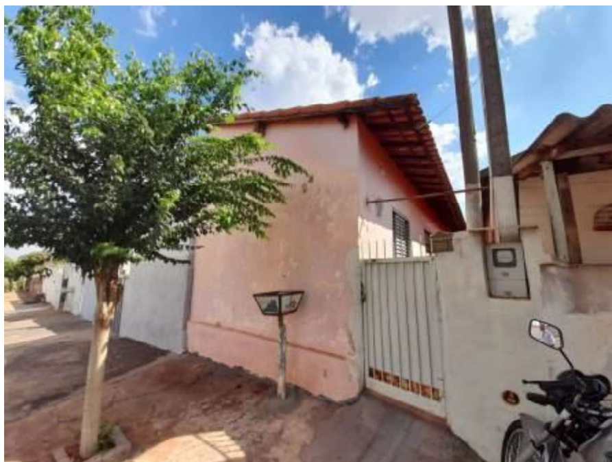
Rua Antônio, 34, Vila Totó
