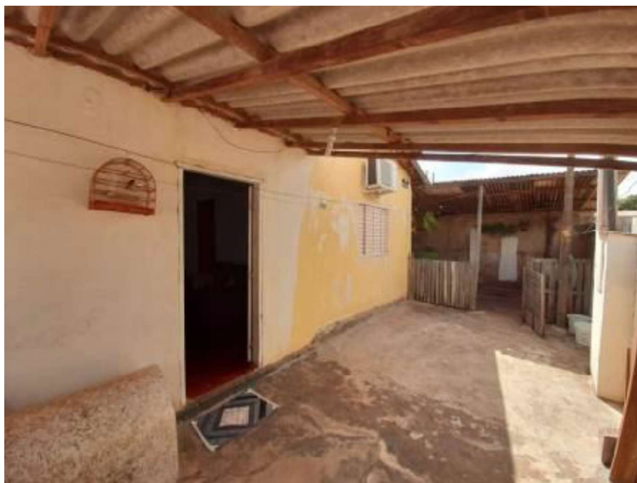
Vista da Varanda
