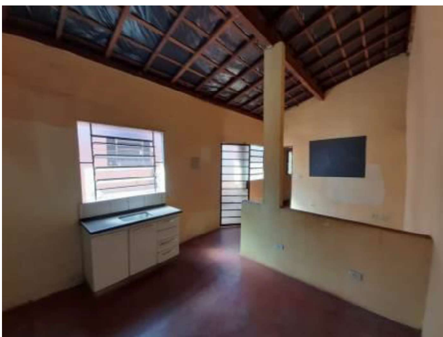
Vista da Cozinha
