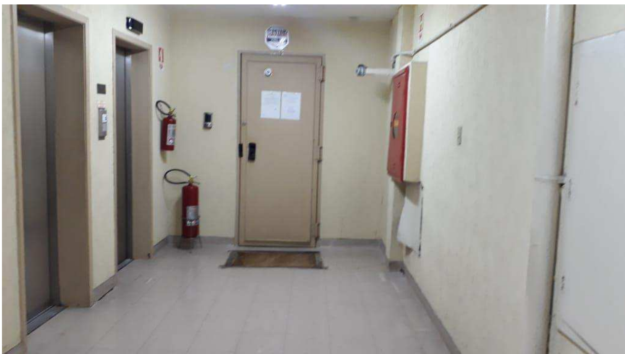
Imagem 05: interior do imóvel.
