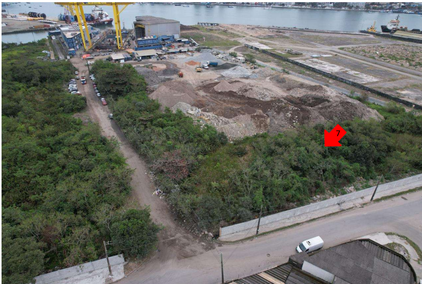
Figura 60 – Vista com indicação das área da QUADRA 7, Rua José Ferreira em leito natural, entre as Quadras 6 e 7 . Fonte: Captação por drone cedida por Assistente técnico parte Exequente (conforme acordado na vistoria).
