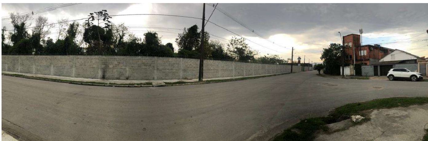
Figura 59 – Vista do Muro e pavimentação do Terreno/Lotes QUADRA 7 a partir Rua Padre Arnaldo Caiaffa. Fonte: Foto Autoral feita in loco na vistoria.
