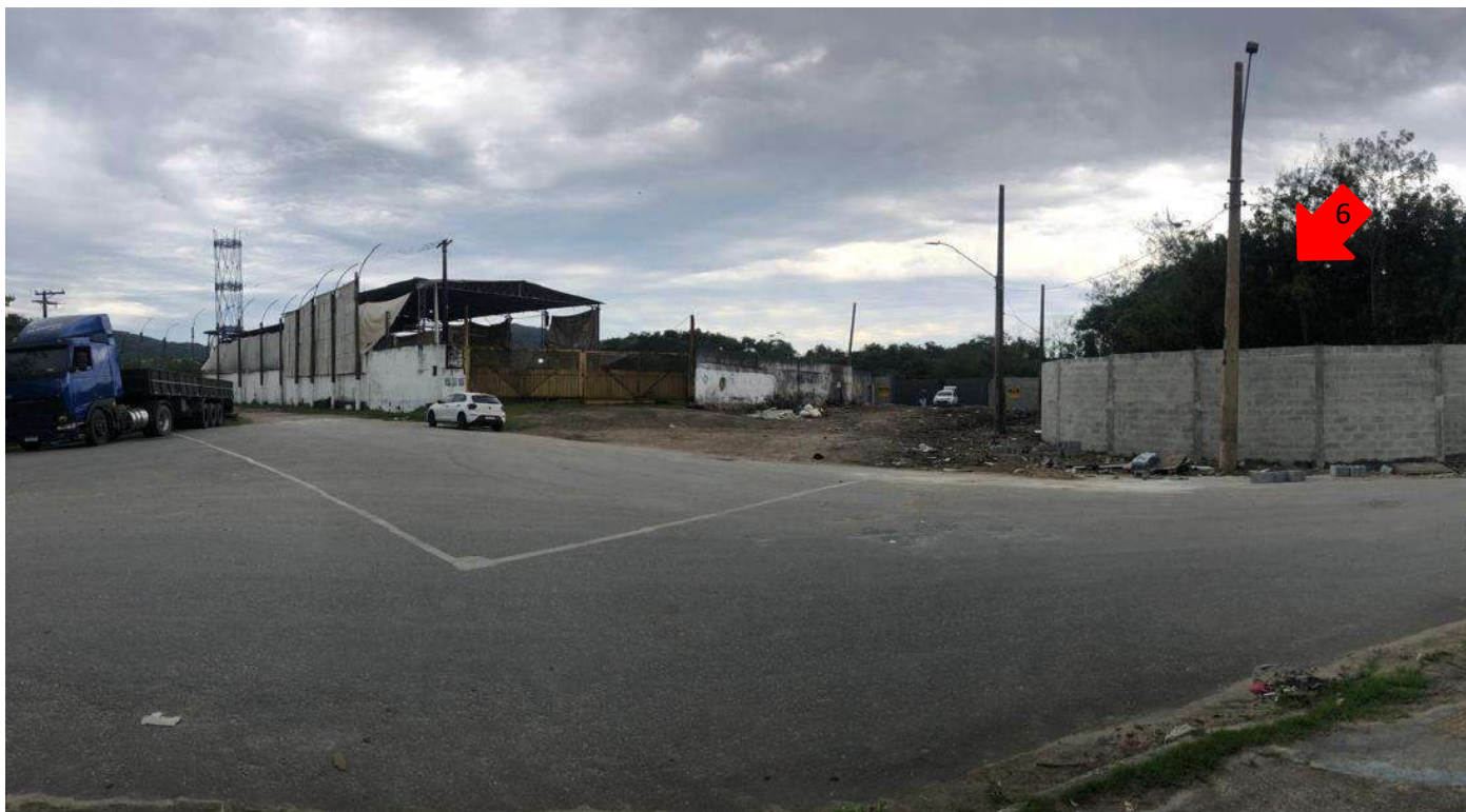
Figura 54 – Vista da esquina da QUADRA 6 a partir da Rua Padre Arnaldo Caiaffa, com a implantação da continuação da Avenida Artur. Fonte: Foto Autoral feita in loco na vistoria.
