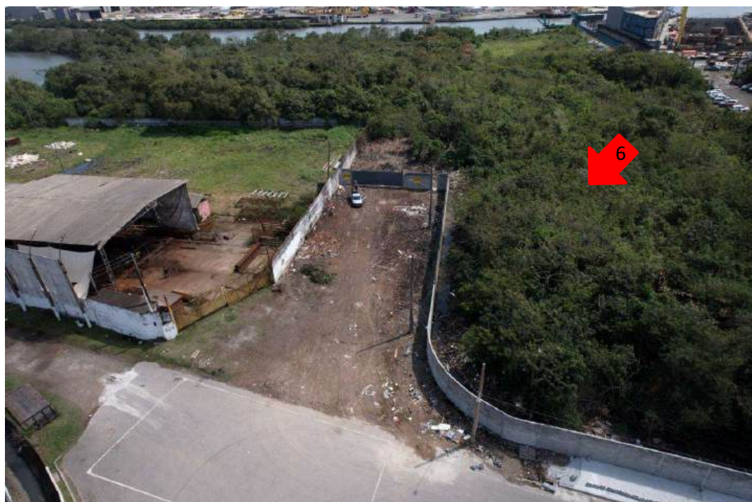
Figura 53 – Vista da área estudada Vila Lygia indicação das área da QUADRA 6 por outro ângulo, esquina da implantação da continuação da Avenida Artur Paixão com a Rua Padre Arnaldo Caiaffa. Fonte: Captação por drone cedida por Assistente técnico parte Exequente (conforme acordado na vistoria).
