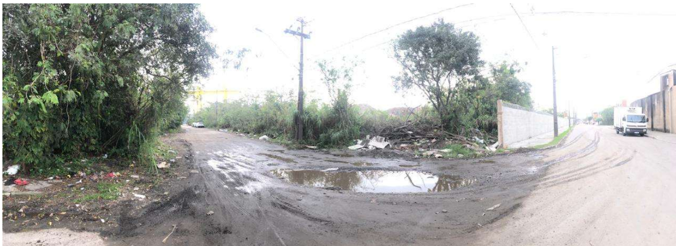
Figura 58 – Vista da esquina da QUADRA 7 Rua José Ferreira em leito natural e Rua Padre Arnaldo Caiaffa. Fonte: Foto Autoral feita in loco na vistoria.
