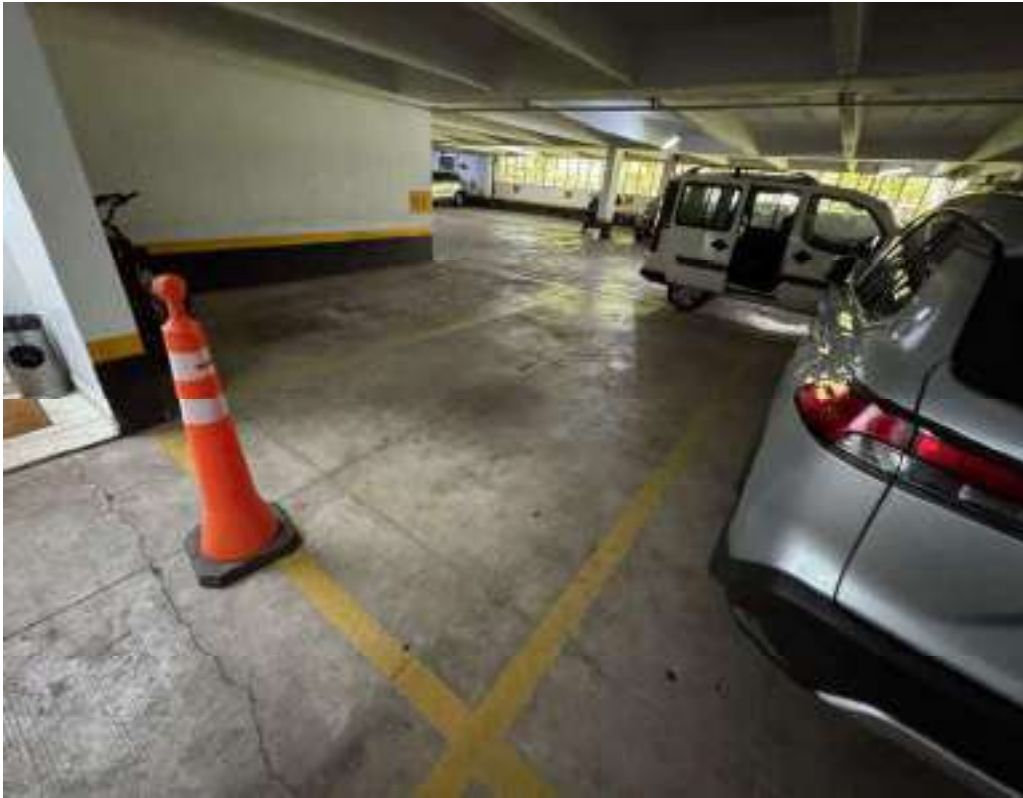
Fotografia 04 – Aspecto geral da vaga de estacionamento E-184.
