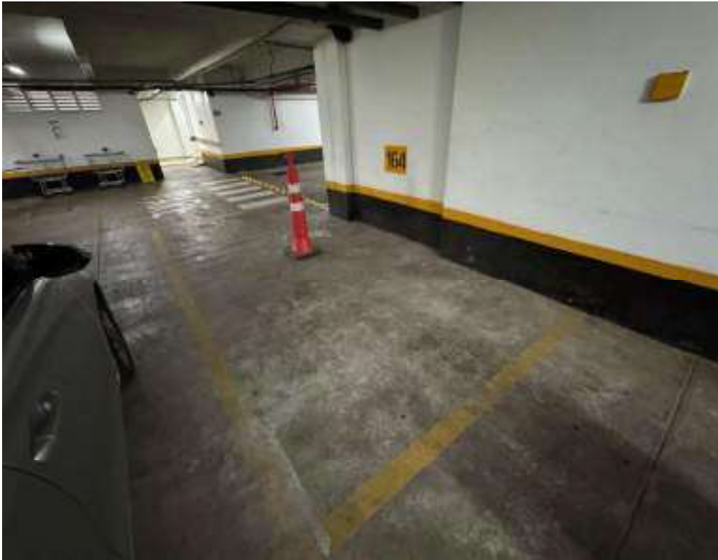
Fotografia 02 –Aspecto geral da vaga de estacionamento E-164.
