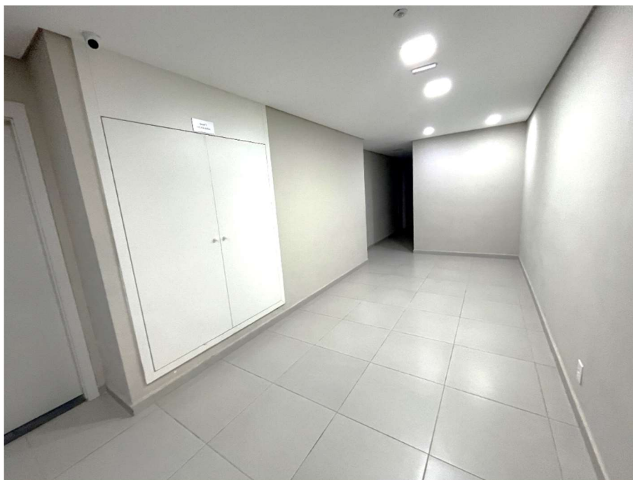
Foto 16 – Hall social no pavimento térreo da Torre 1
