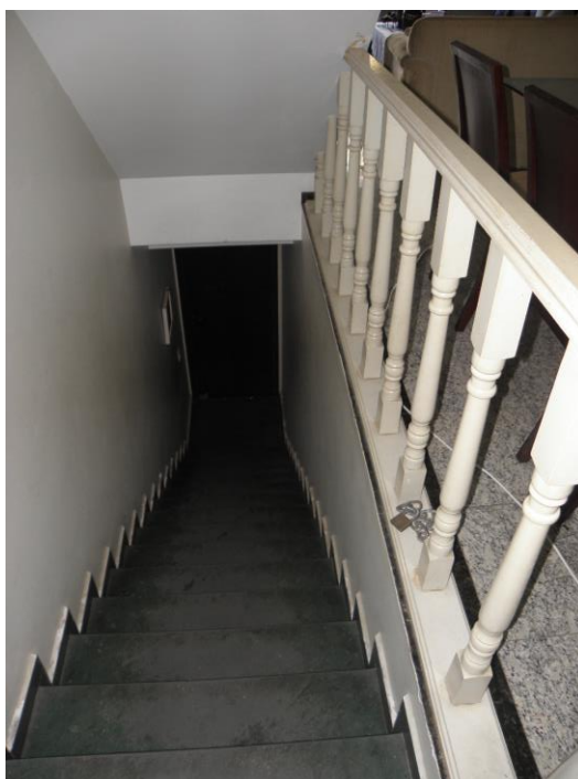
Foto: escada de acesso ao 1o pavimento.
