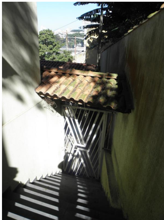
Foto: escada lateral de acesso.
