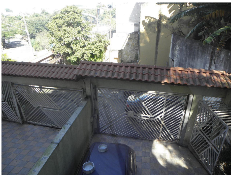
Foto: visão do portão de entrada.
