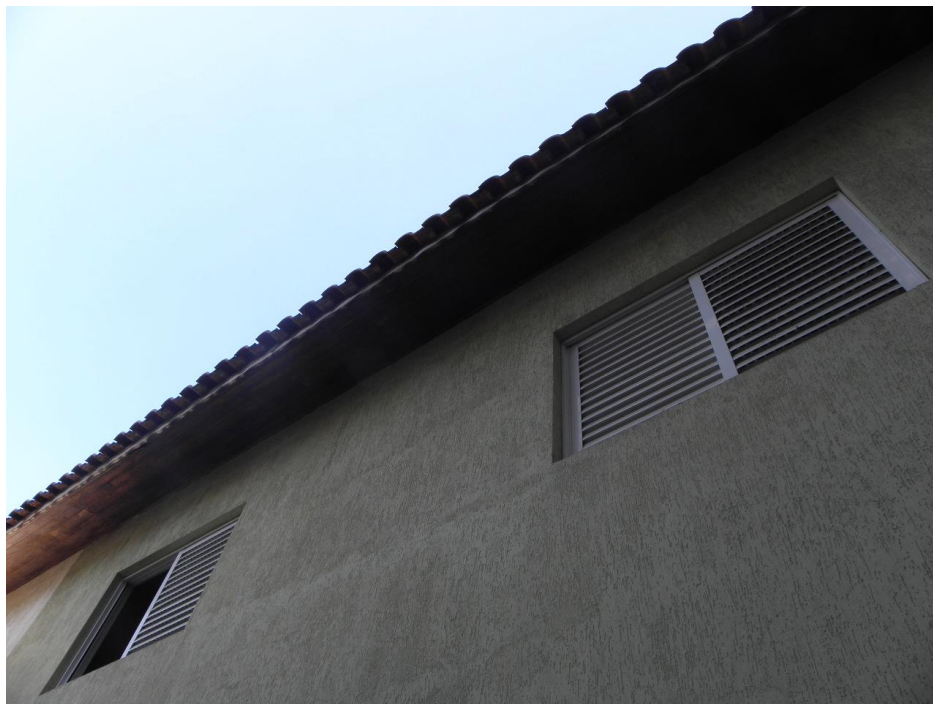
Foto: fachada dos fundos.
