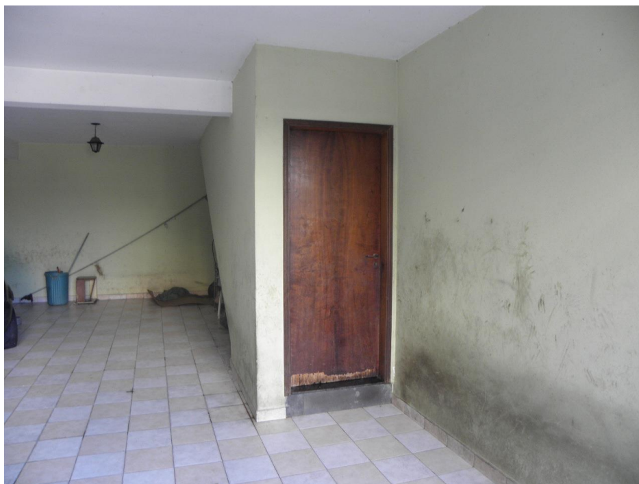
Foto: acesso pela garagem.
