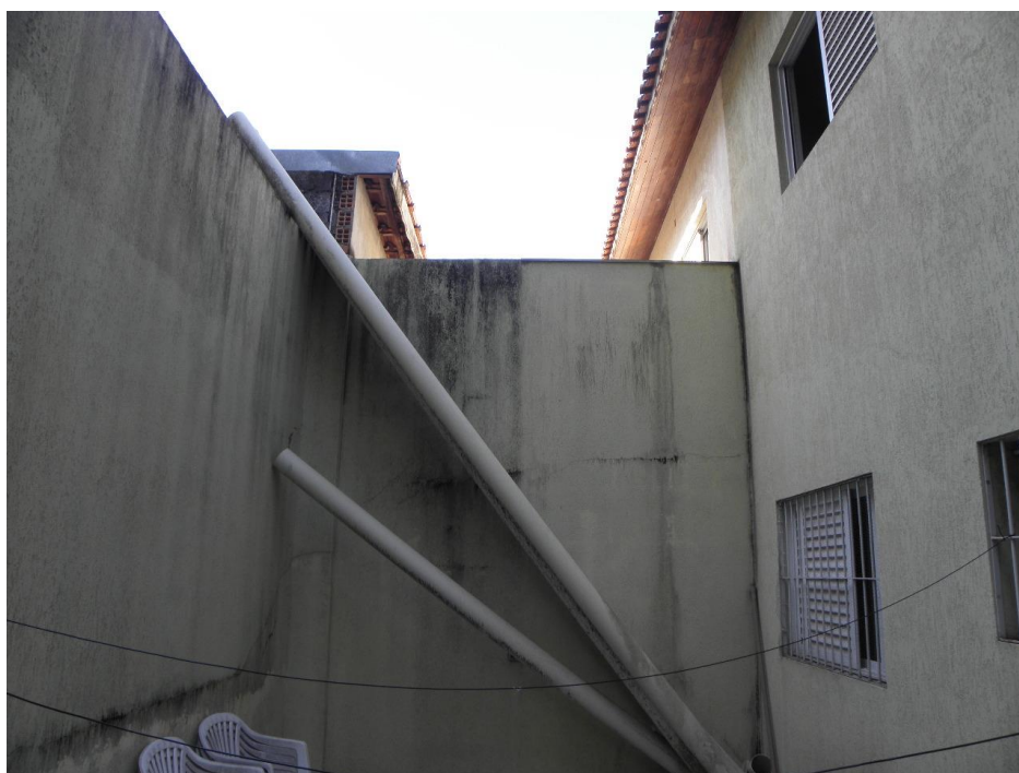
Foto: muro lateral dos fundos.
