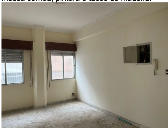
Fig. 13 – Vista de um dos quartos do fundo da unidade revestido com massa corrida e piso cerâmico.
