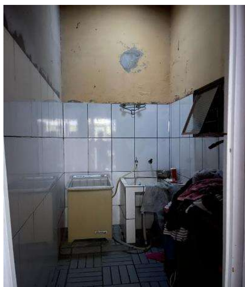
Foto 10 – Área de Serviço
