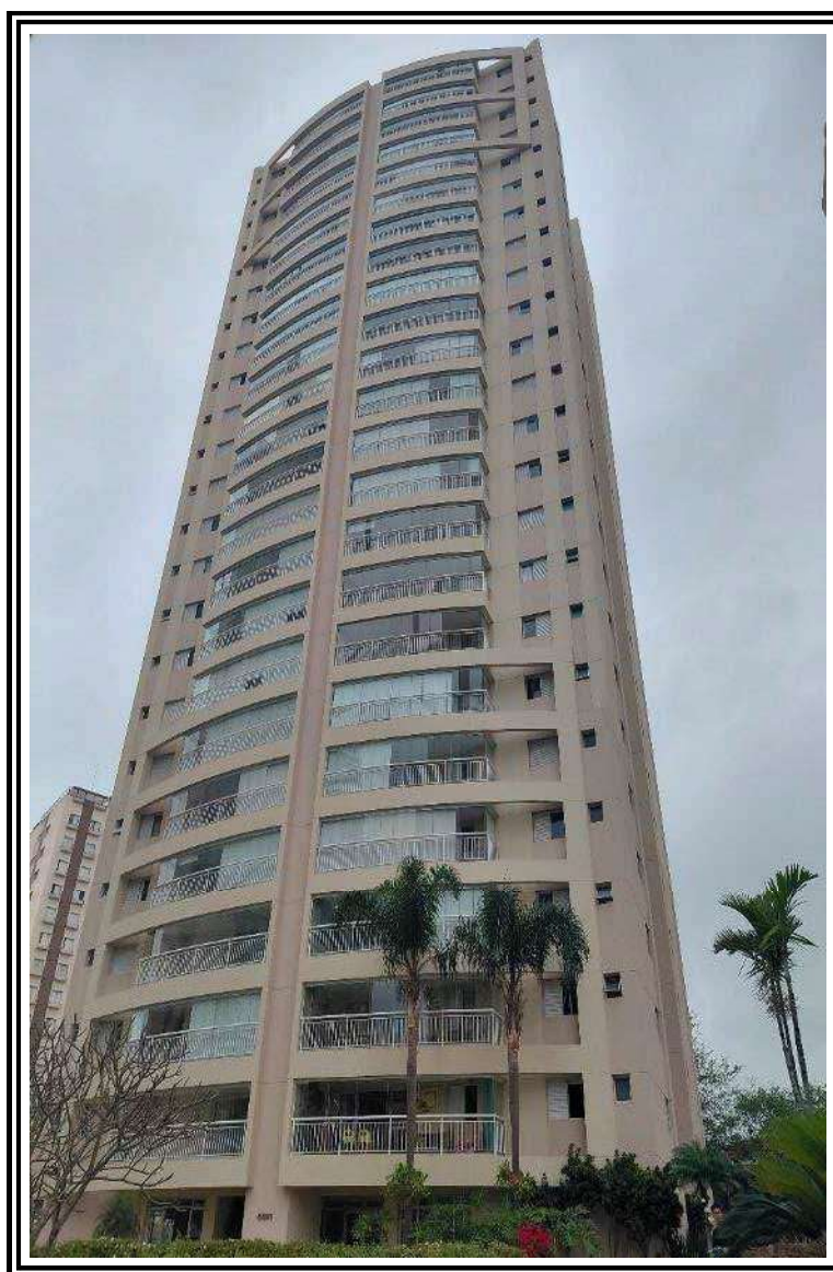
Foto nº 08: Vista do Bloco A (Torre Europe), edifício onde está localizado o imóvel em avaliação
