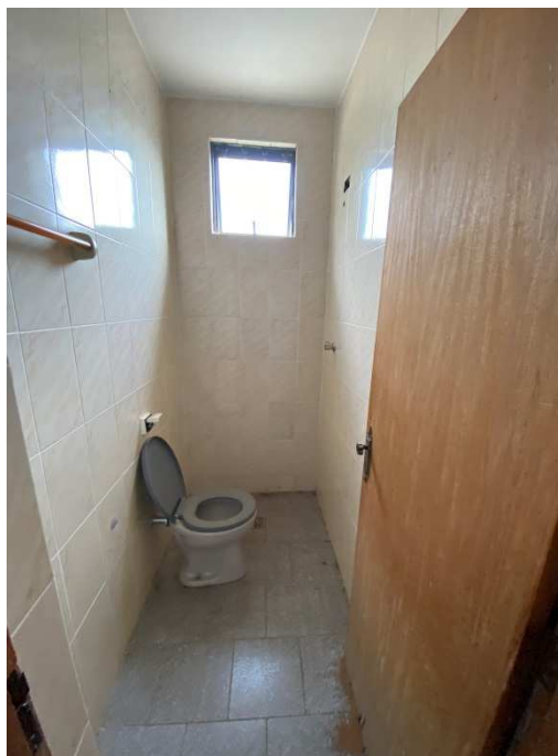
VISTA DO BANHEIRO.
