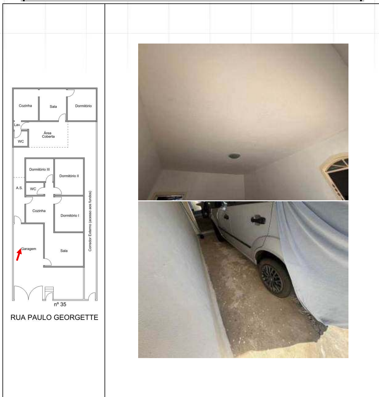
DETALHES DOS ACABAMENTOS DO TETO E PISO DA GARAGEM.
