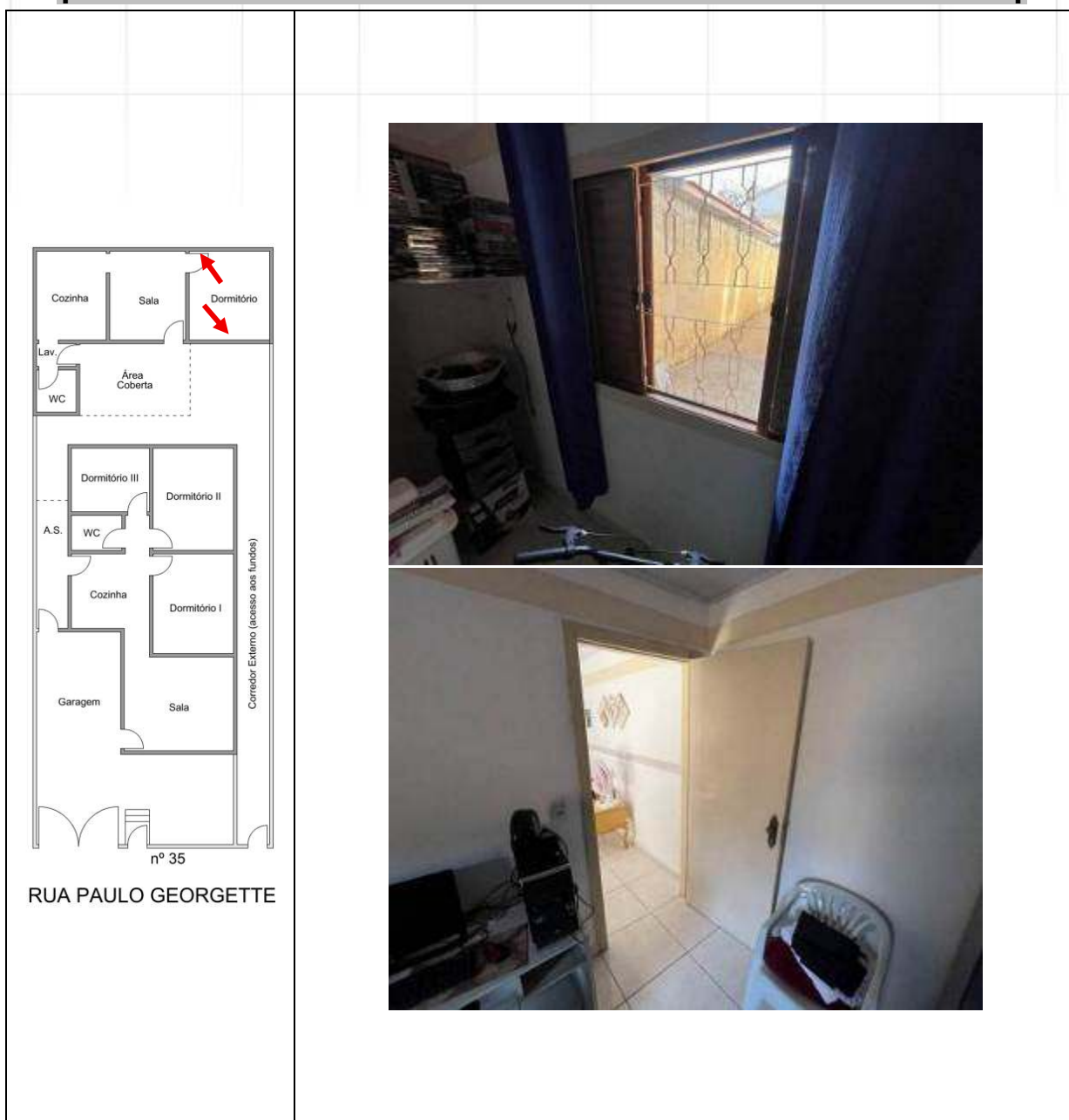
DETALHES DA JANELA E PORTA DO DORMITÓRIO DA EDÍCULA.
