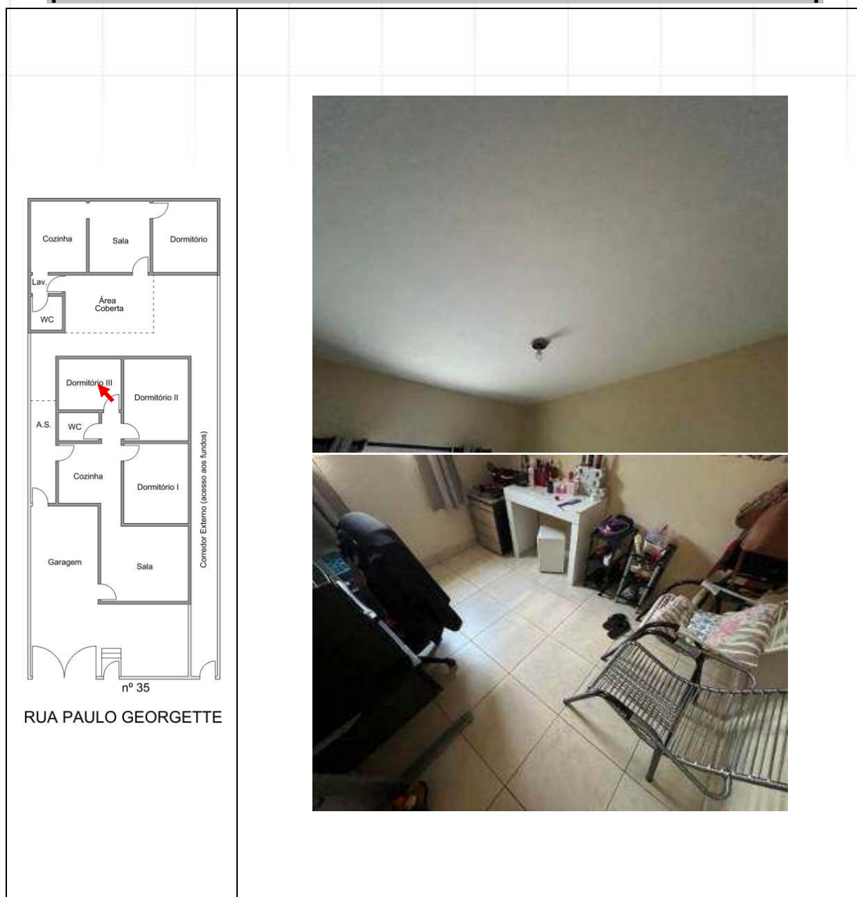
DETALHES DOS ACABAMENTOS DO TETO E PISO DO DORMITÓRIO III.
