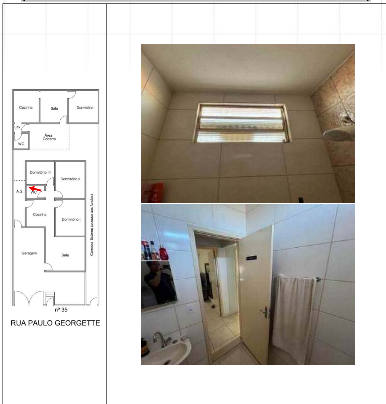
DETALHES DA JANELA E PORTA DO BANHEIRO.
