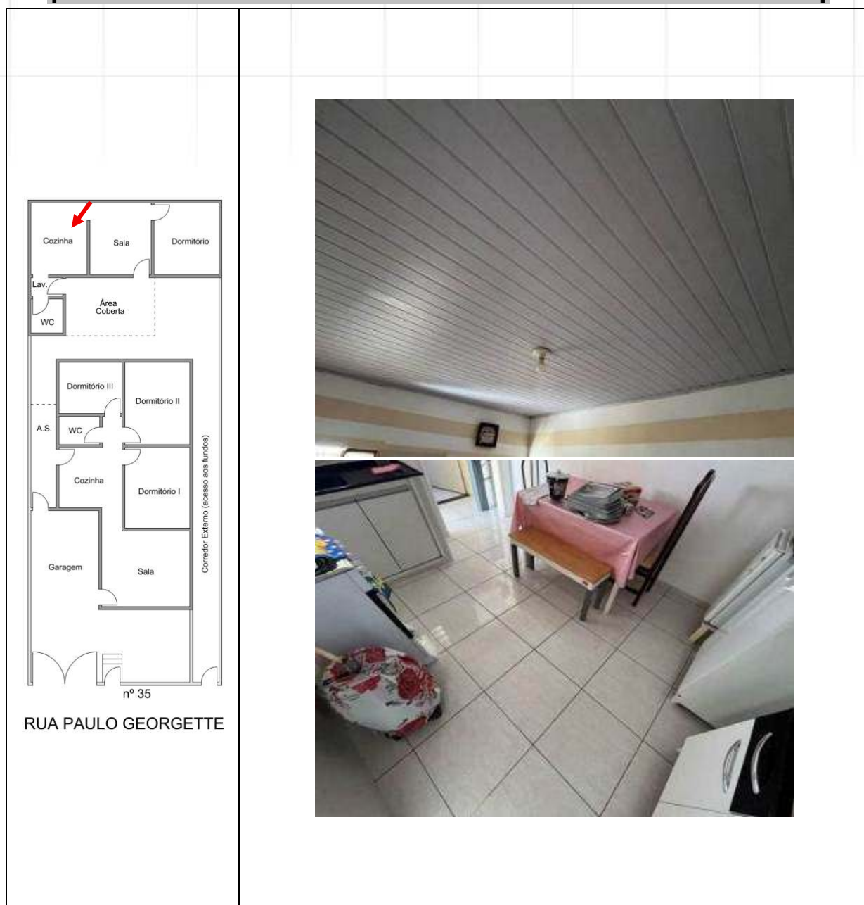
DETALHES DOS ACABAMENTOS DO TETO E PISO DA COZINHA DA EDÍCULA.
