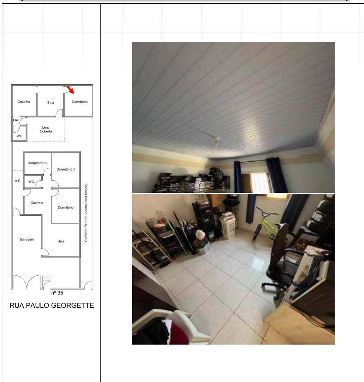
DETALHES DOS ACABAMENTOS DO TETO E PISO DO DORMITÓRIO DA EDÍCULA.
