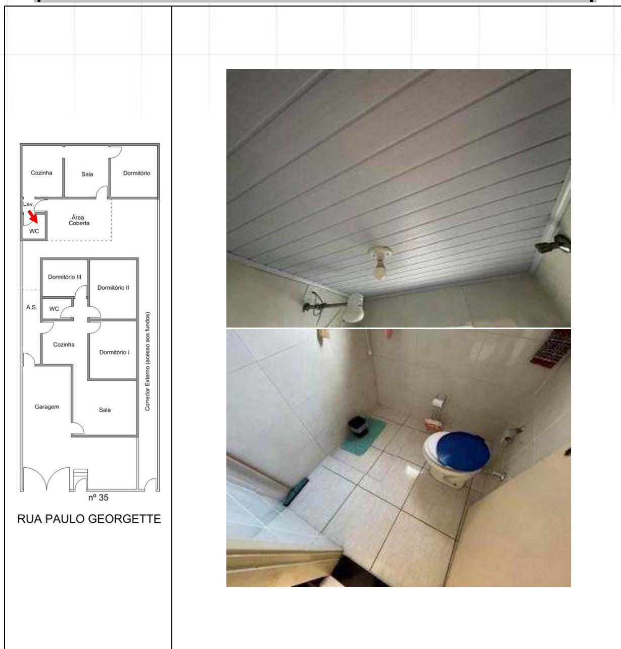
DETALHES DOS ACABAMENTOS DO TETO E PISO DO BANHEIRO DA EDÍCULA.
