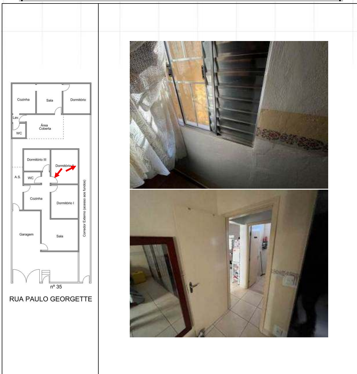
DETALHES DA JANELA E PORTA DO DORMITÓRIO II.
