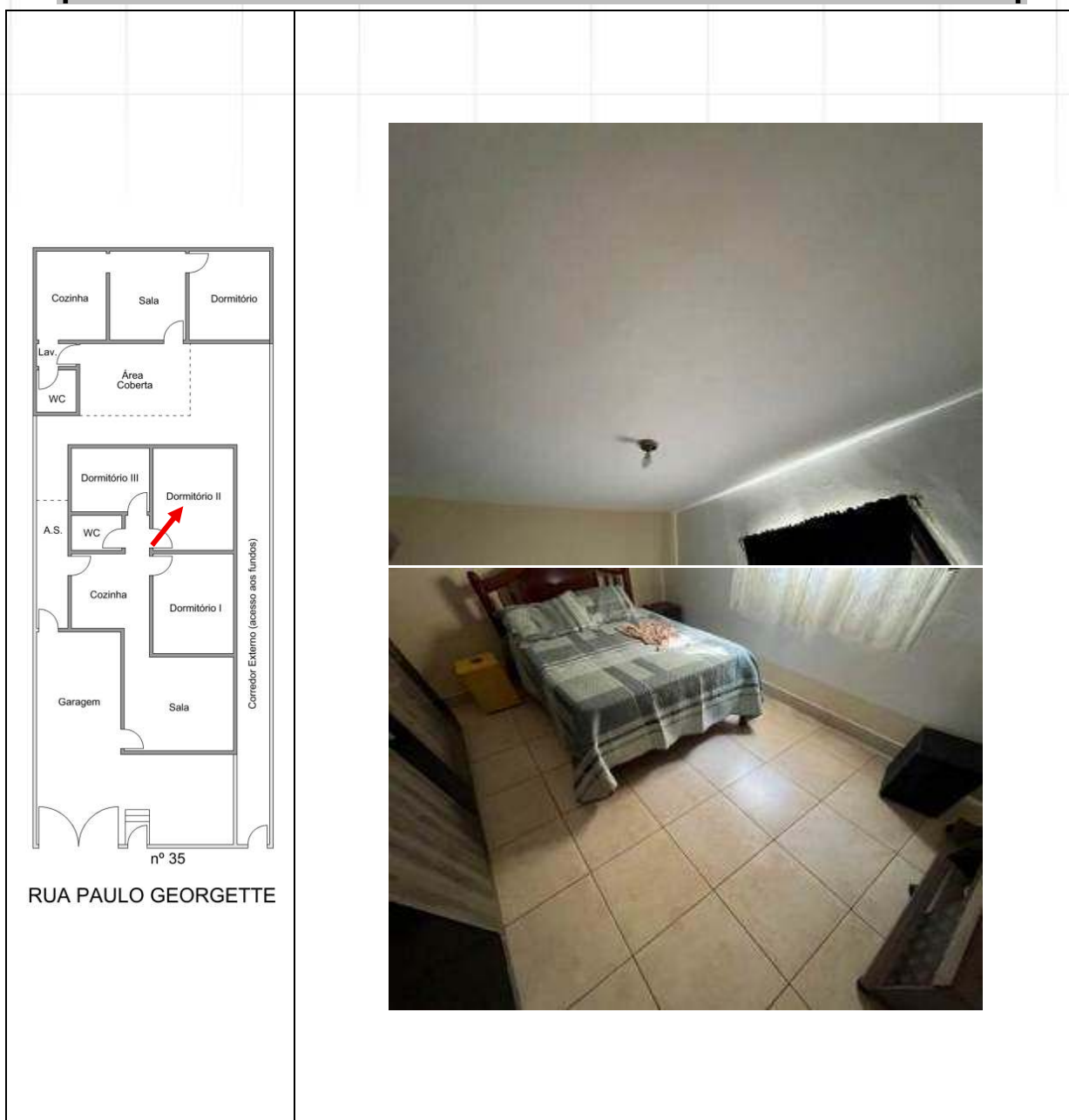
DETALHES DOS ACABAMENTOS DO TETO E PISO DO DORMITÓRIO II.
