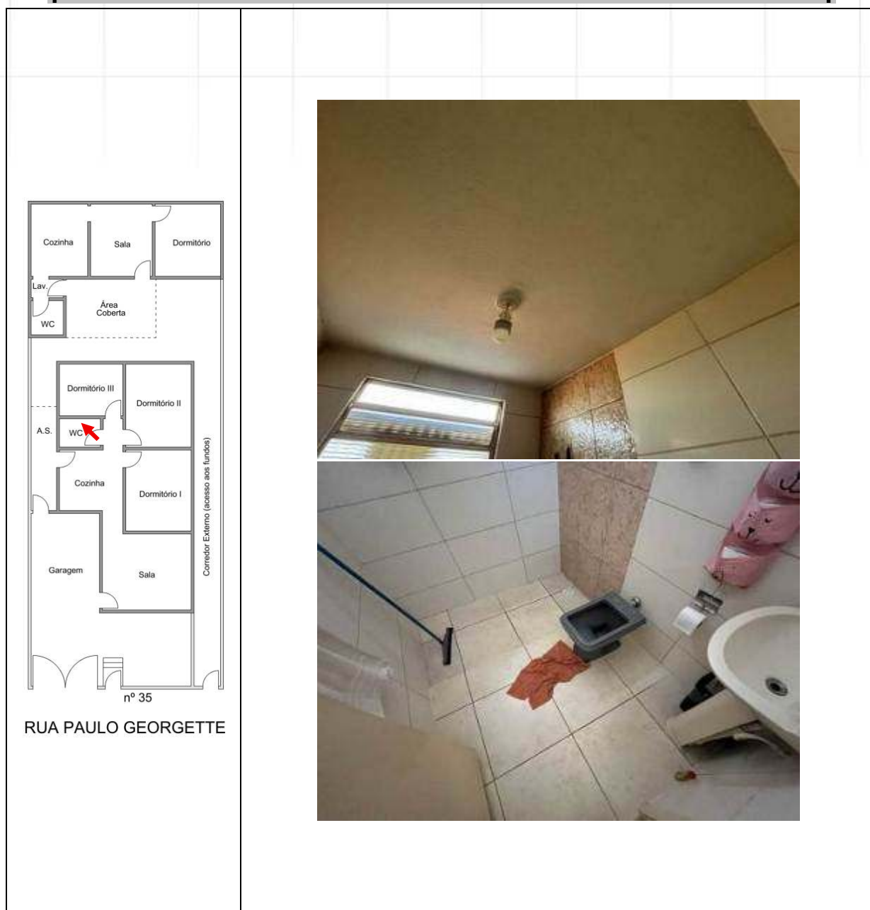
DETALHES DOS ACABAMENTOS DO TETO E PISO DO BANHEIRO.
