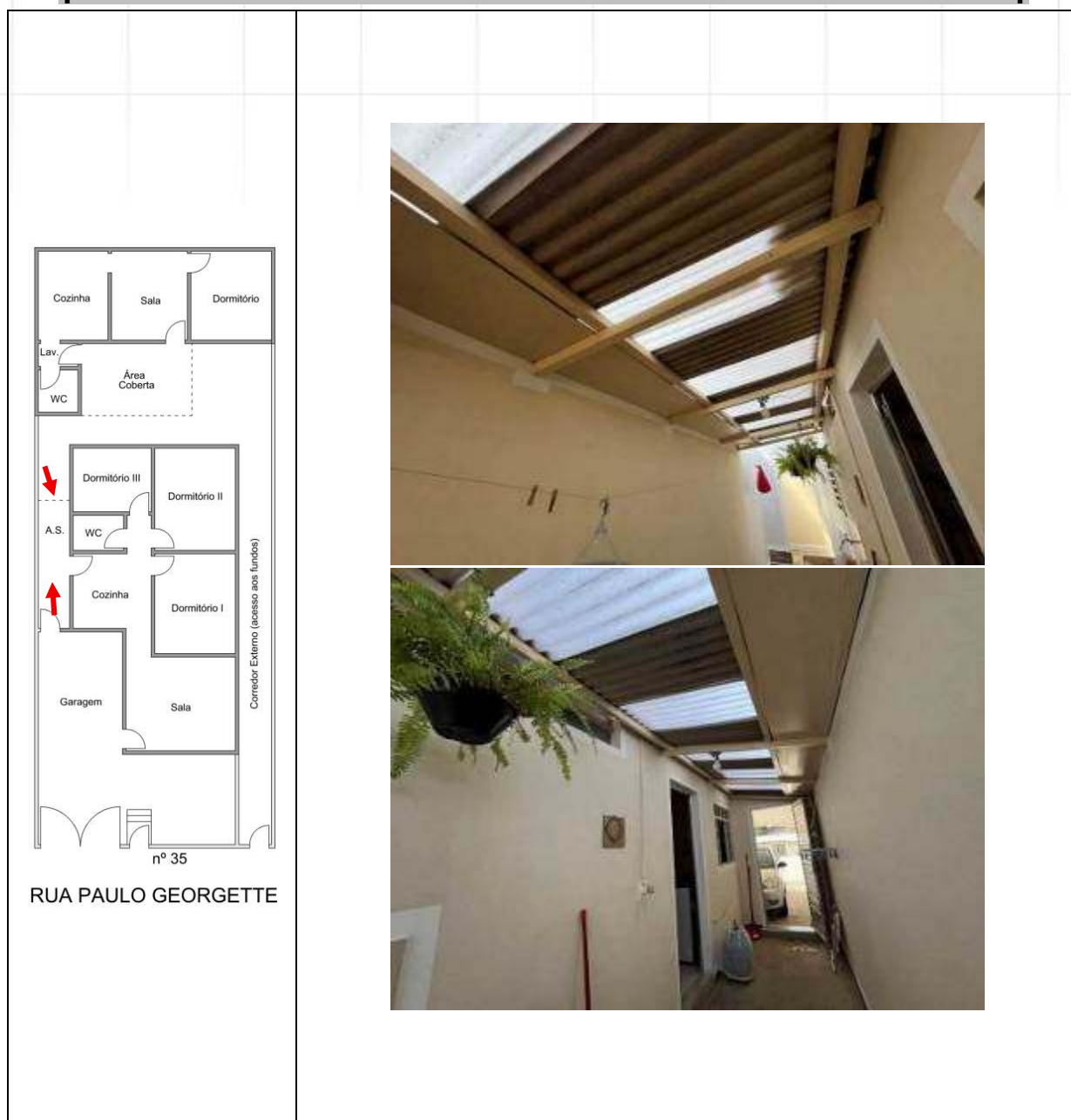
DETALHE DA COBERTURA DO CORREDOR EXTERNO.
