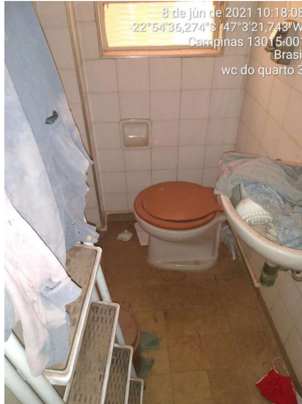
FOTO 17 – BANHEIRO DO ESCRITÓRIO
