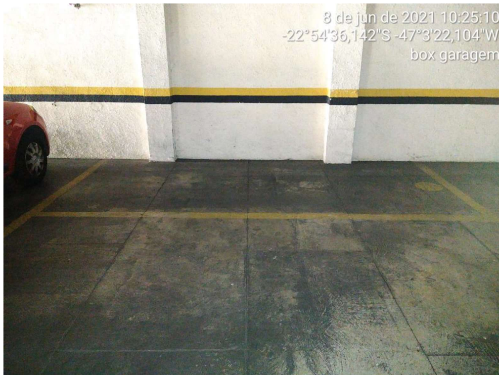
FOTO 22 – BOX DE GARAGEM
