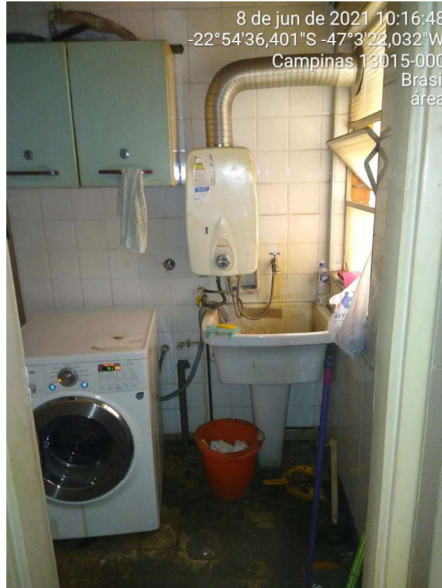
FOTO 21 – ÁREA DE SERVIÇO
