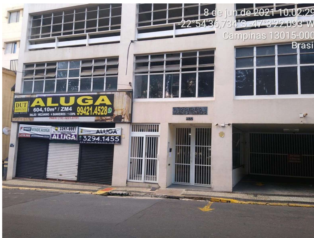
FOTO 03 – FACHADA DO EDIFÍCIO
