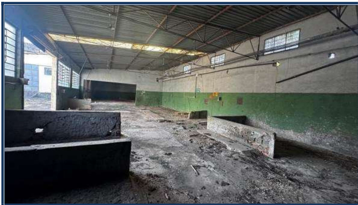
Vista interna das edificações.
