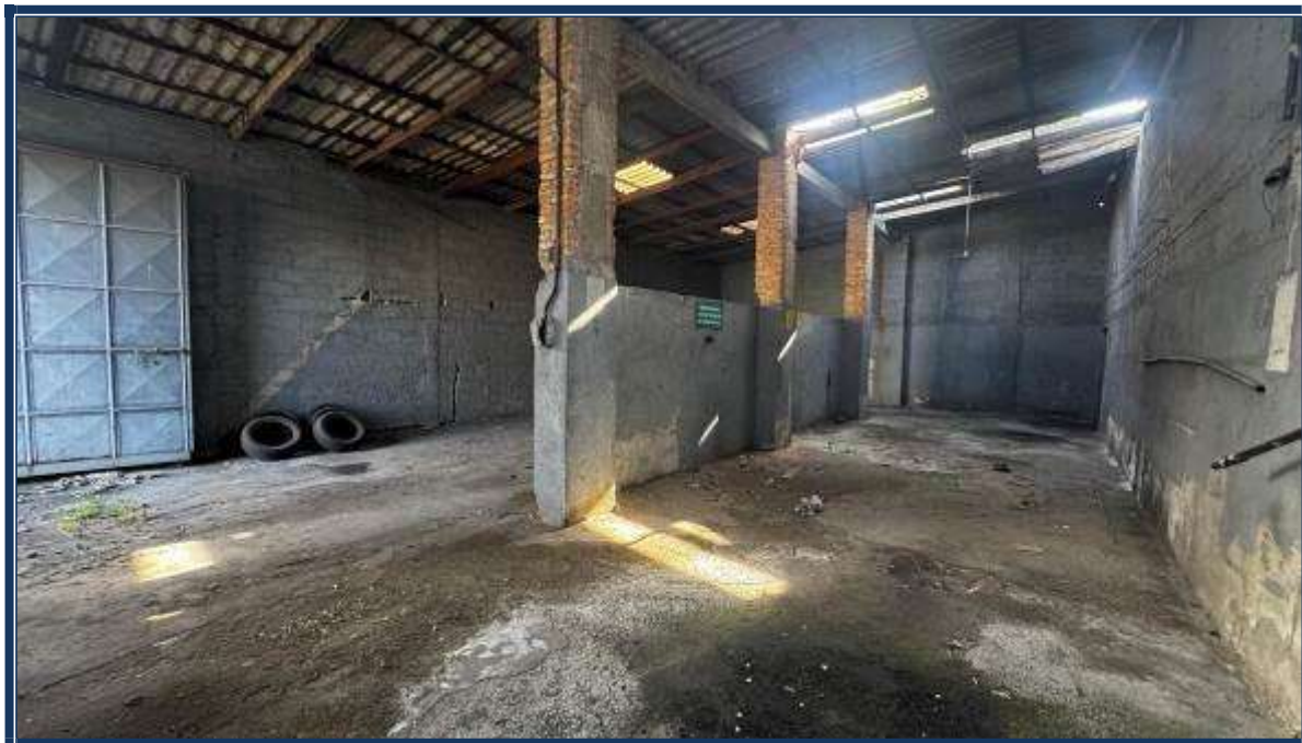
Vista interna das edificações.
