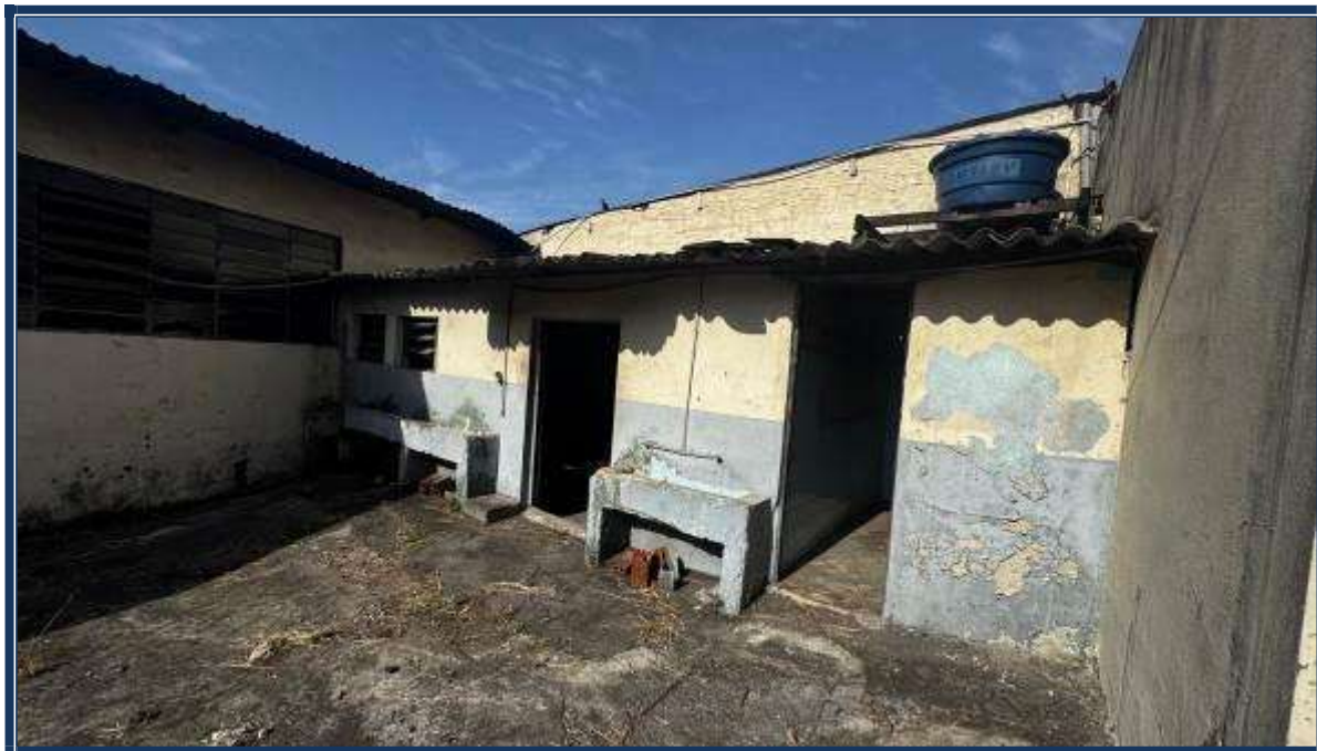
Vista interna das edificações.
