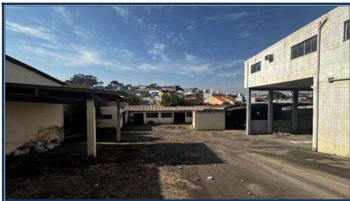
Vista interna das edificações.
