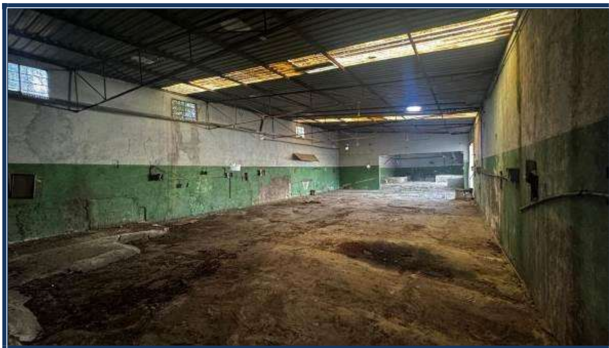
Vista interna das edificações.
