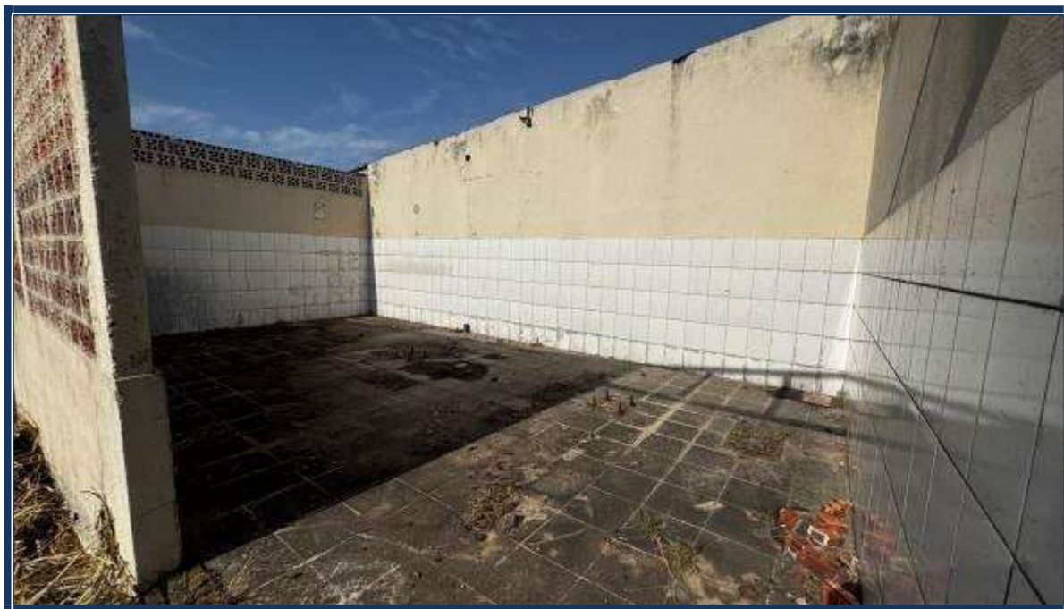
Vista interna das edificações.
