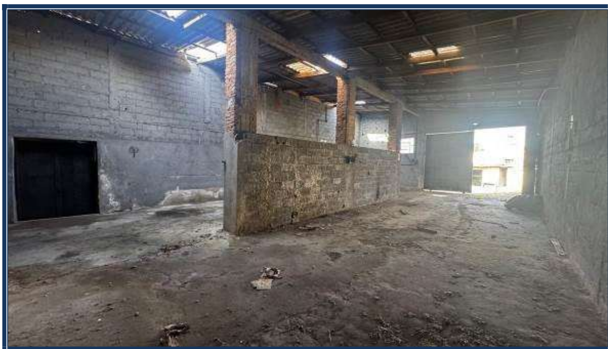
Vista interna das edificações.
