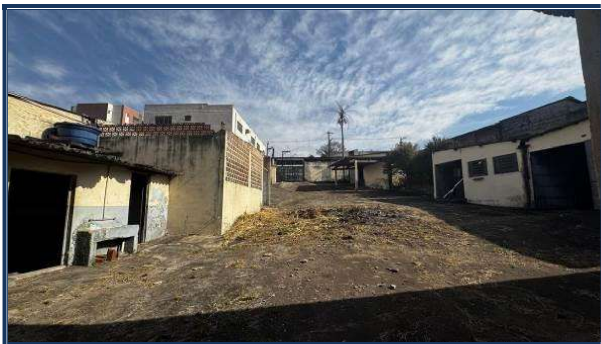
Vista interna das edificações.
