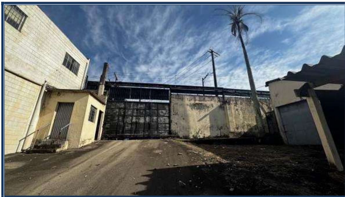
Vista interna das edificações.
