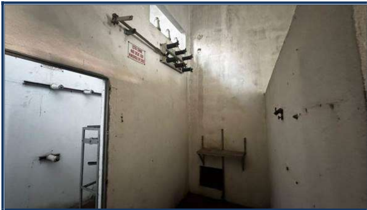
Vista interna das edificações.
