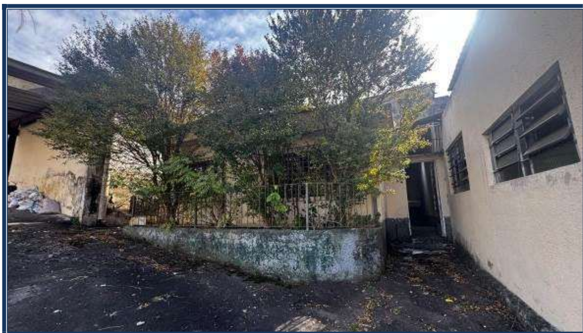
Vista interna das edificações.
