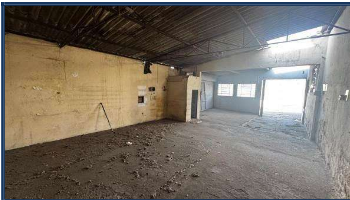
Vista interna das edificações.
