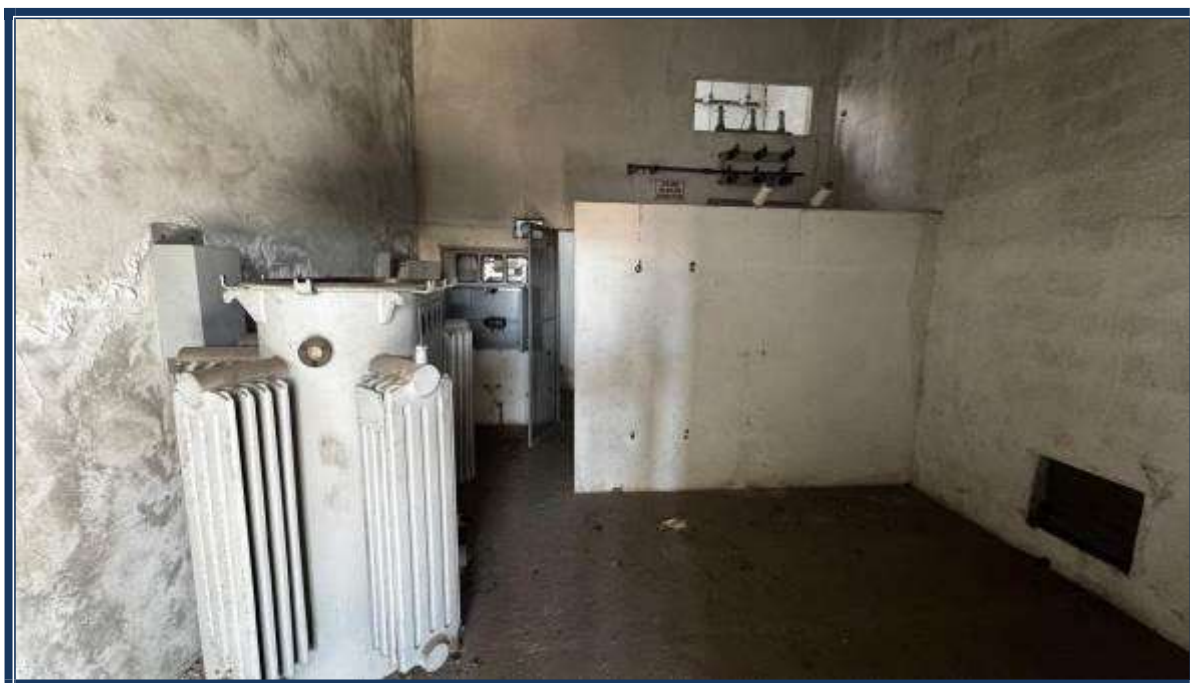
Vista interna das edificações.
