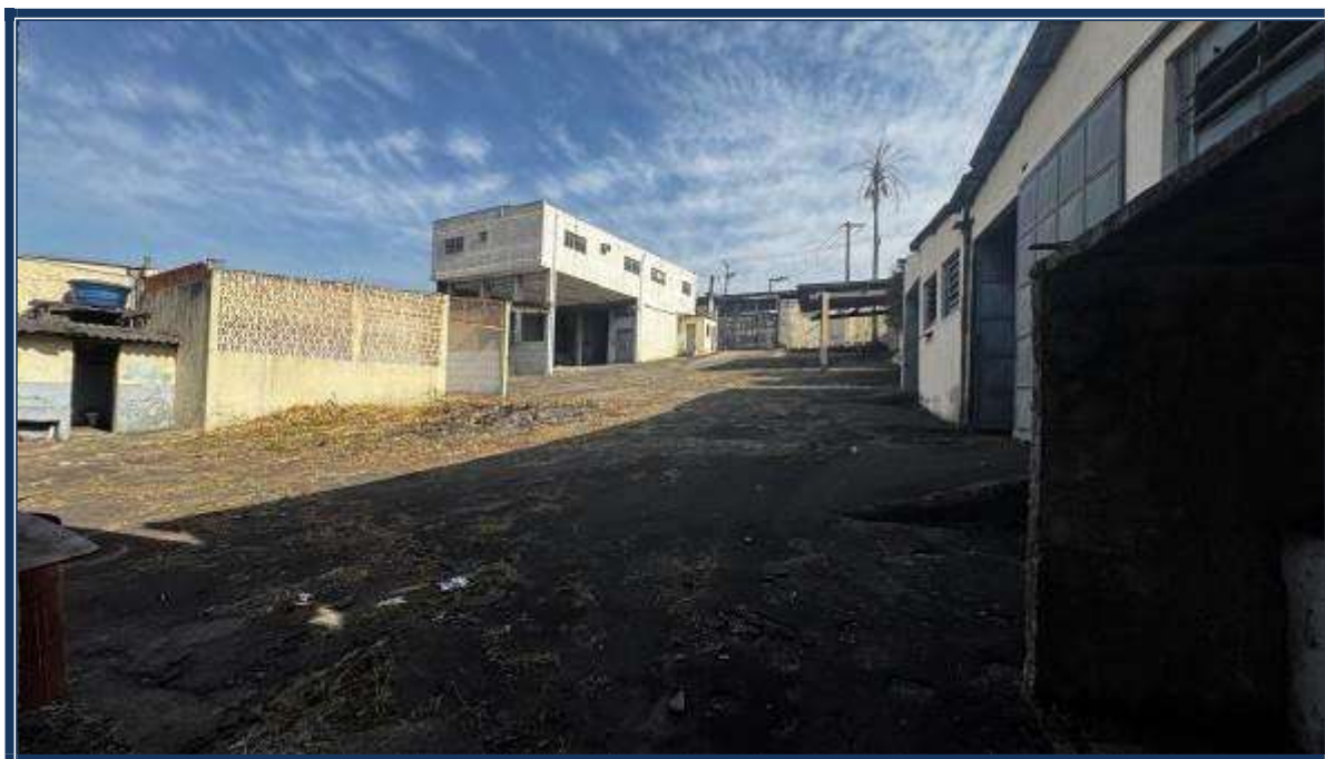
Vista interna das edificações.
