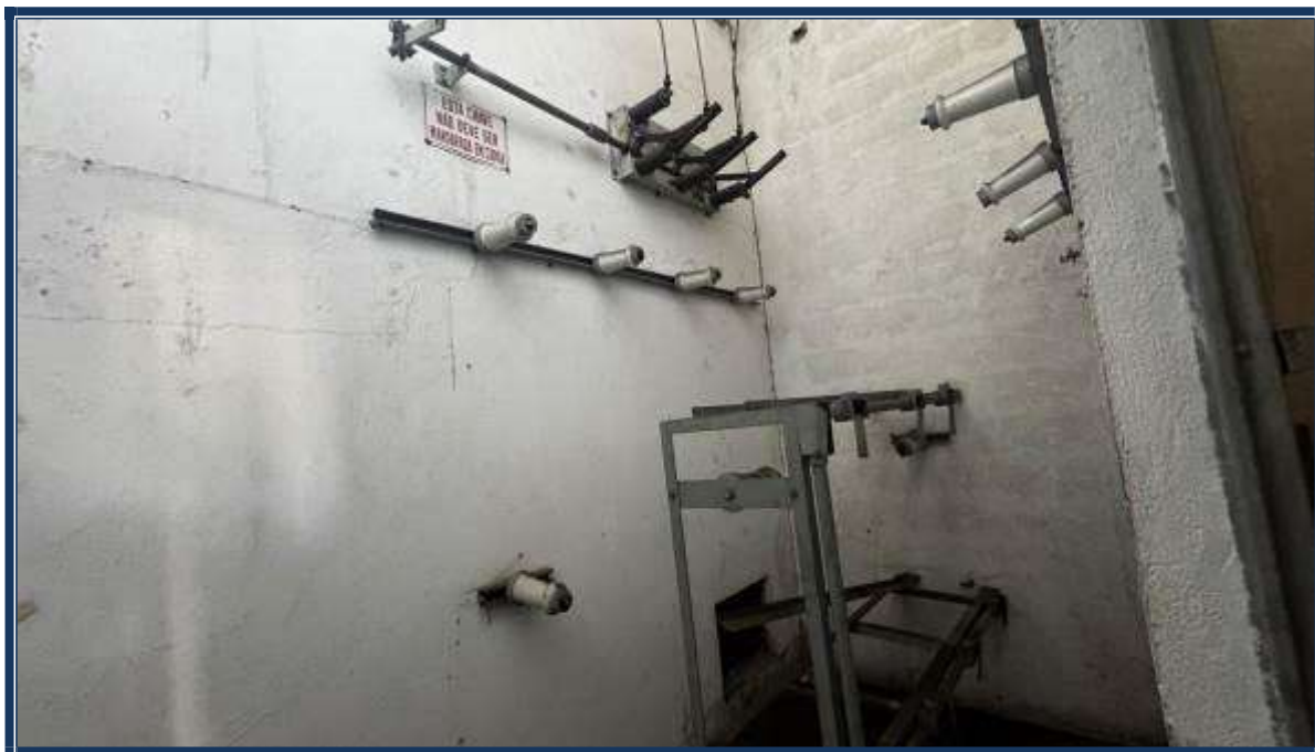
Vista interna das edificações.
