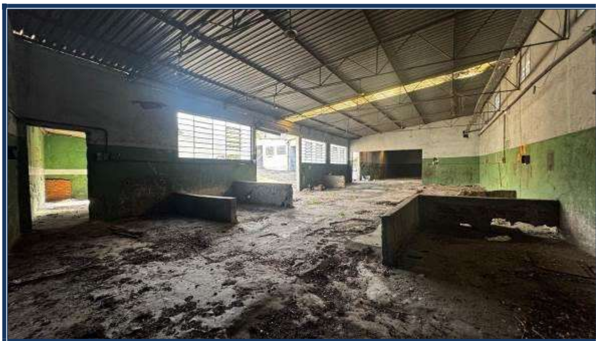
Vista interna das edificações.
