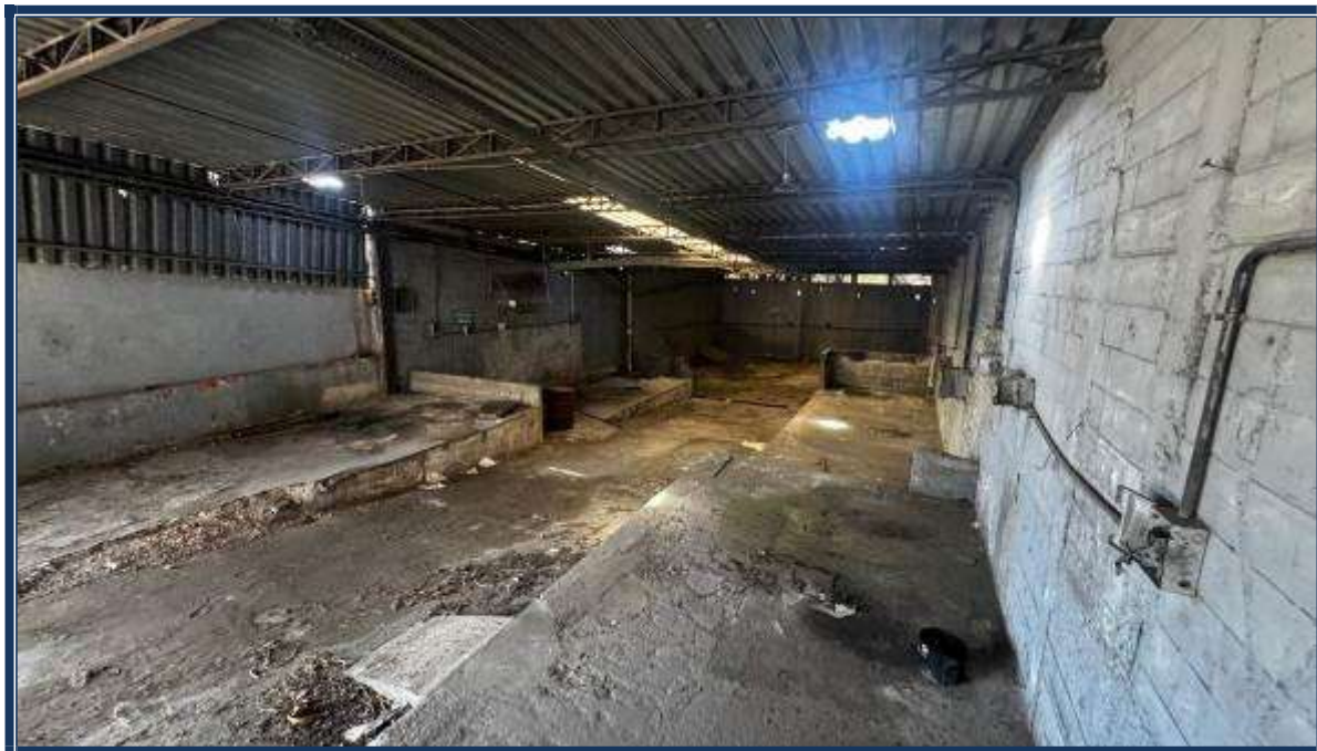
Vista interna das edificações.
