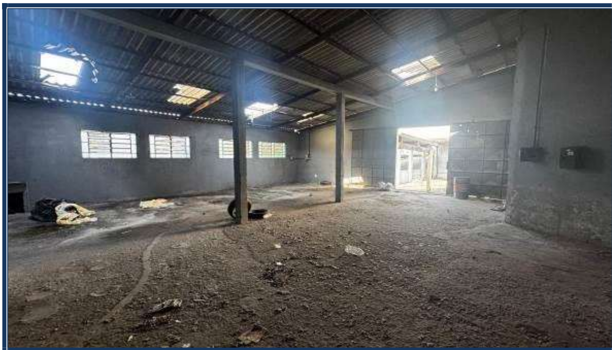
Vista interna das edificações.
