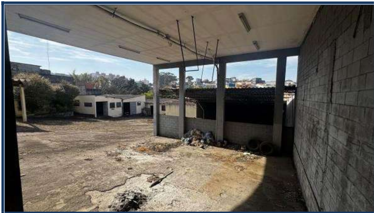
Vista interna das edificações.
