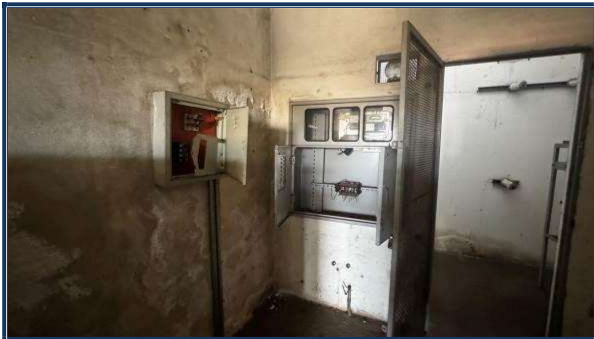
Vista interna das edificações.
