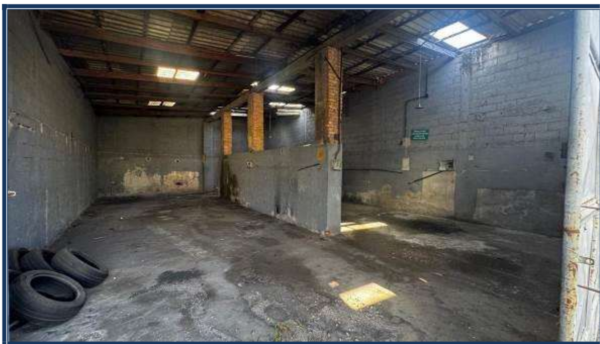
Vista interna das edificações.
