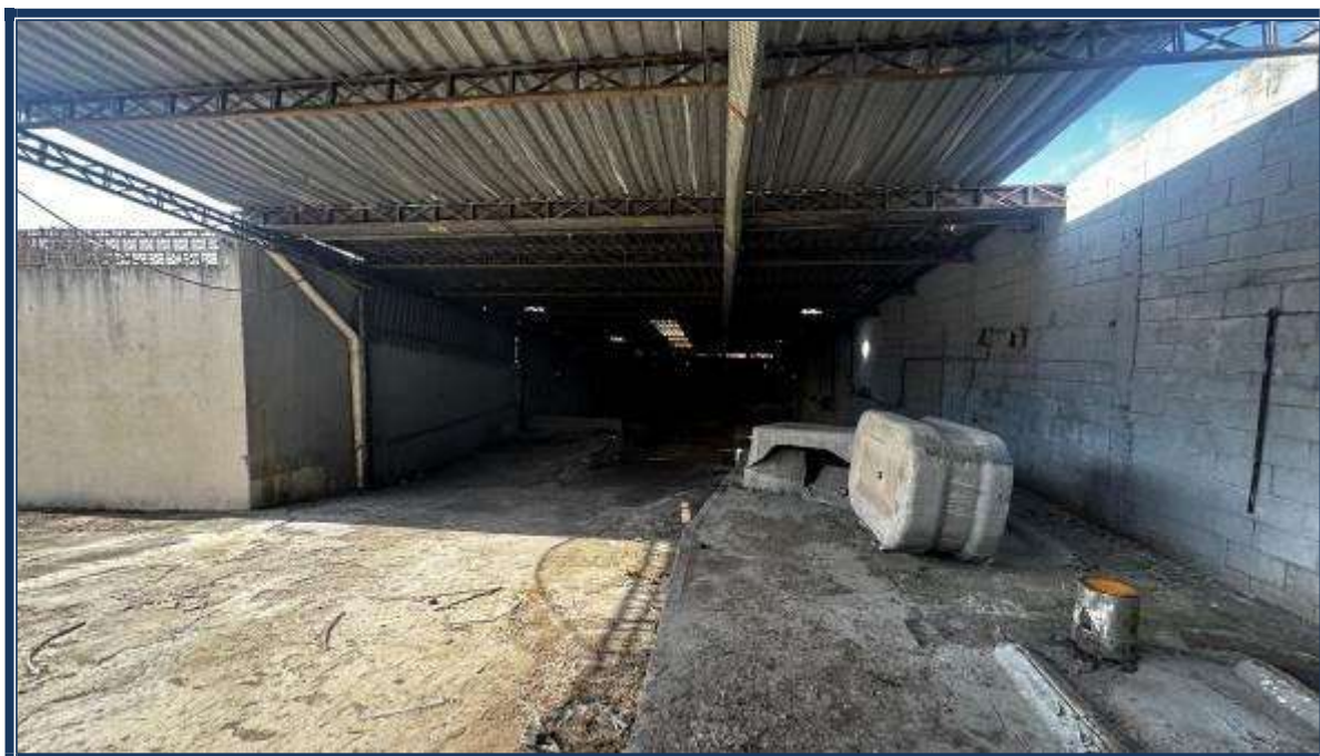
Vista interna das edificações.
