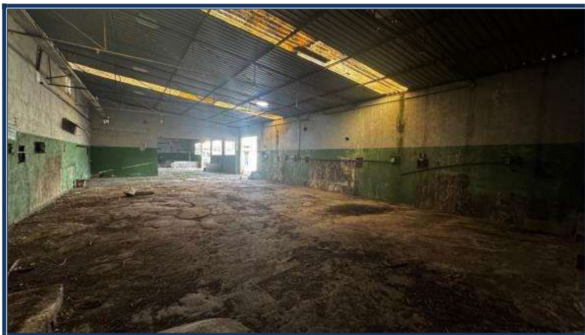
Vista interna das edificações.
