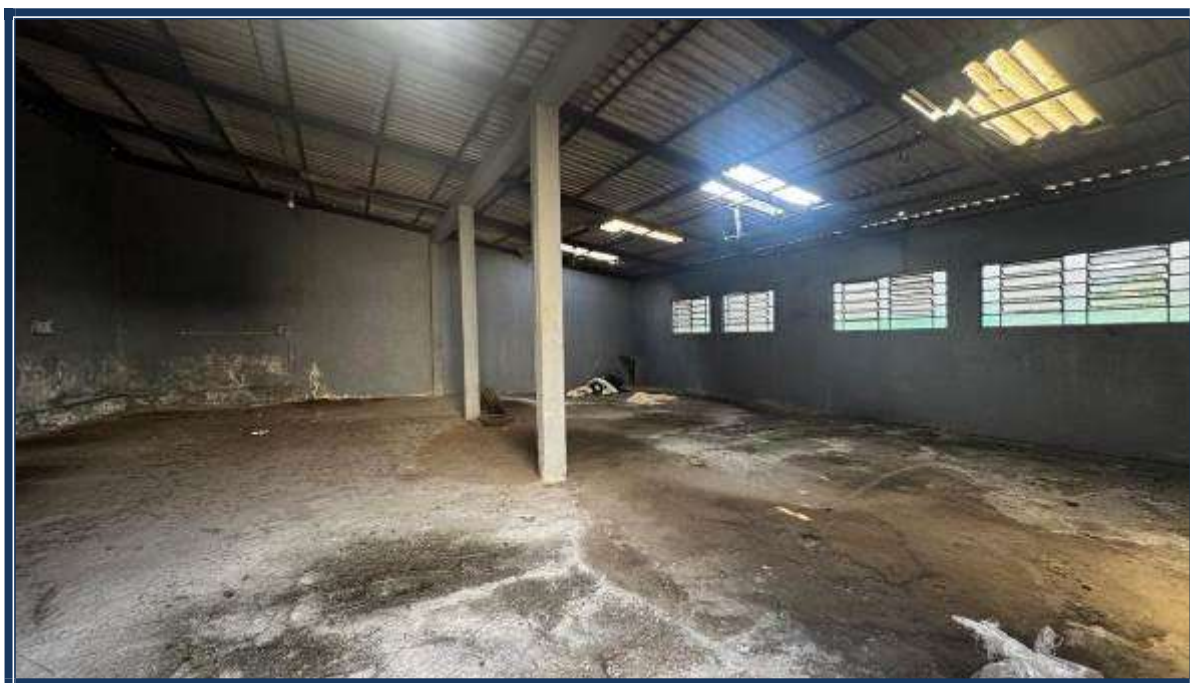
Vista interna das edificações.
