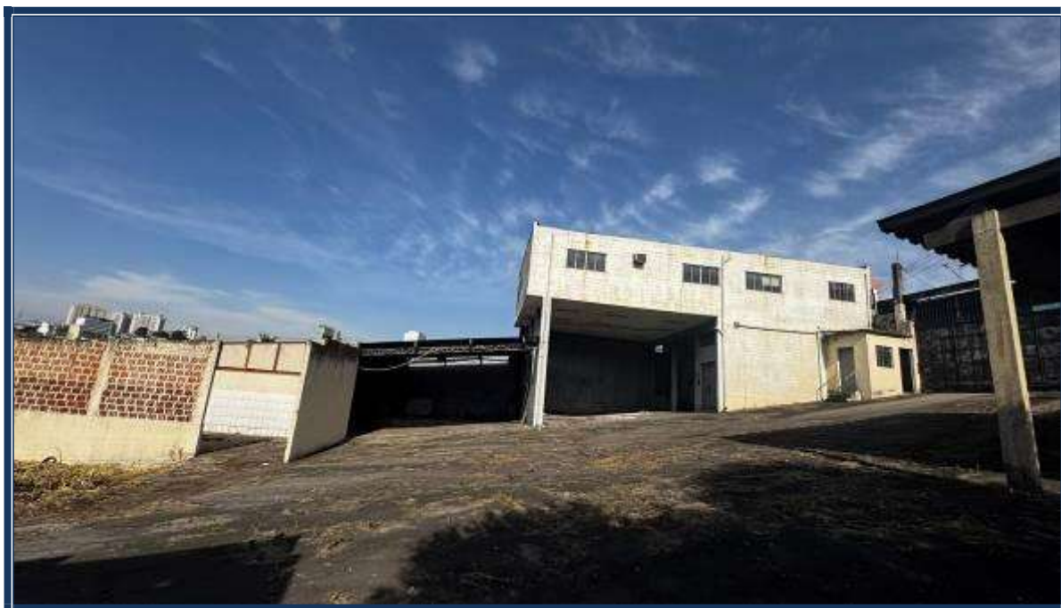
Vista interna das edificações.
