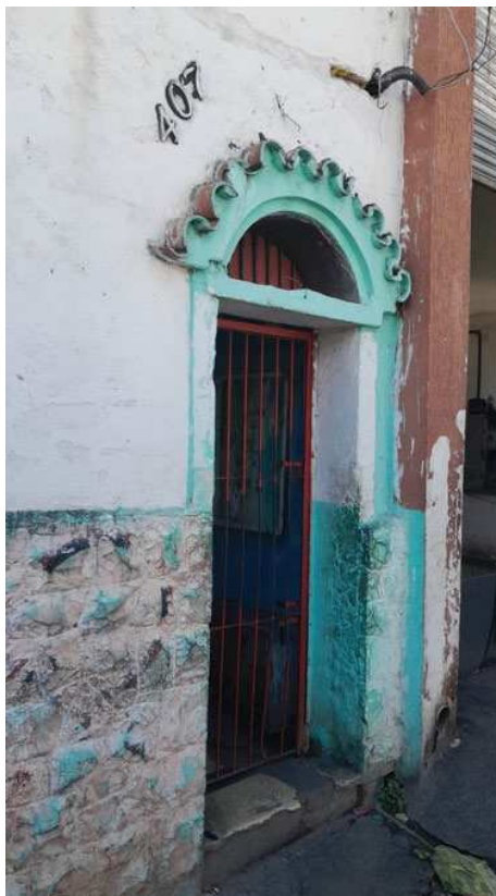
Foto 03 - Vista geral da identificação do imóvel periciando.
