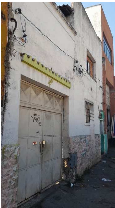
Foto 02 - Vista geral da fachada do imóvel periciando.
