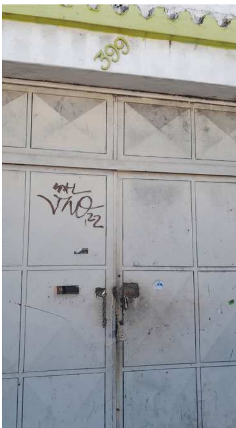
Foto 04 - Vista geral da identificação do imóvel periciando.
