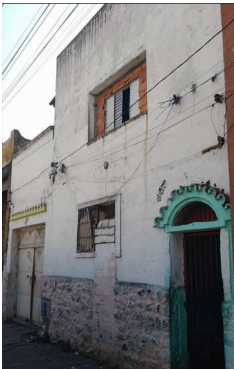
Foto 01 - Vista geral da fachada do imóvel periciando.
