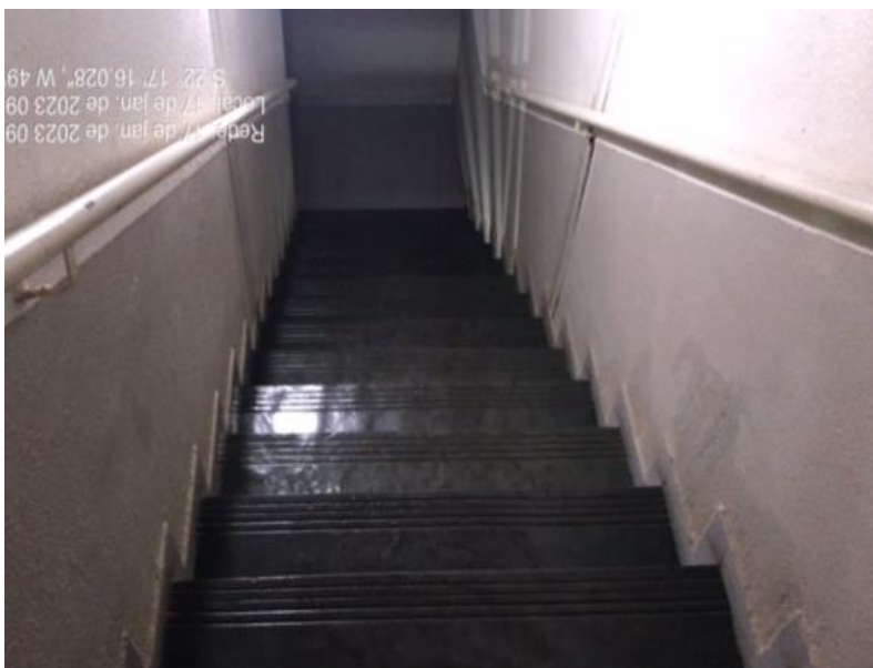
Detalhe do interior do bloco.
