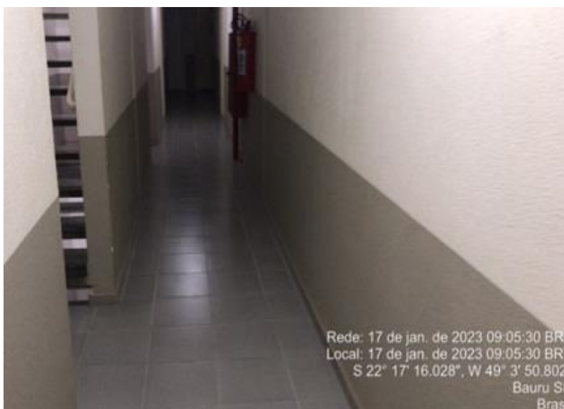
Detalhe do interior do bloco.
