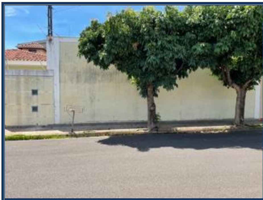
Vista da frente do imóvel avaliando.
