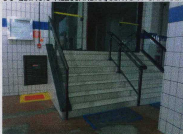
FOTO 04 - DETALHE DA ENTRADA INTERNA DO EDIFÍCIO ALESSANDRA, JUNTO À GARAGEM.
