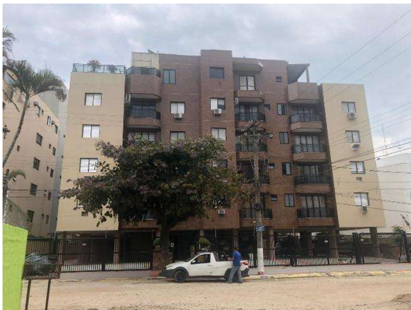
Figura 7 – Vista do Edifício HERMON.
