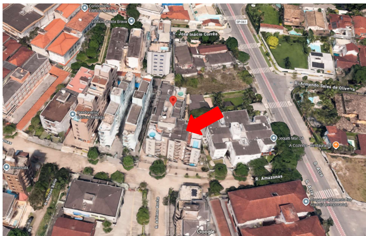
Figura 3 – Imagem vista por Satélite, do Edifício HERMON, indicado em vermelho. Fonte: Google Maps.
