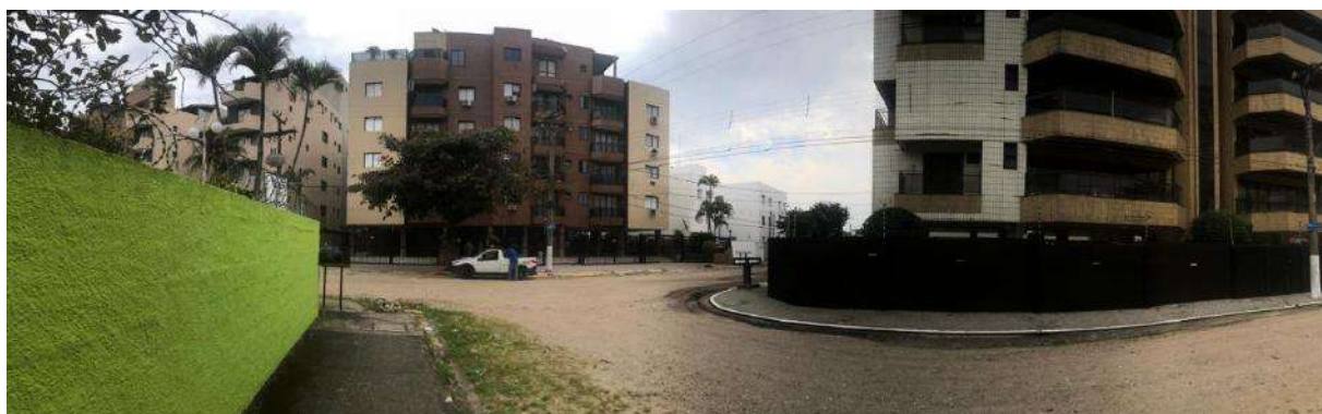
Figura 8 – Vista do Edifício avaliado a partir da Rua Adriano Rocha.
