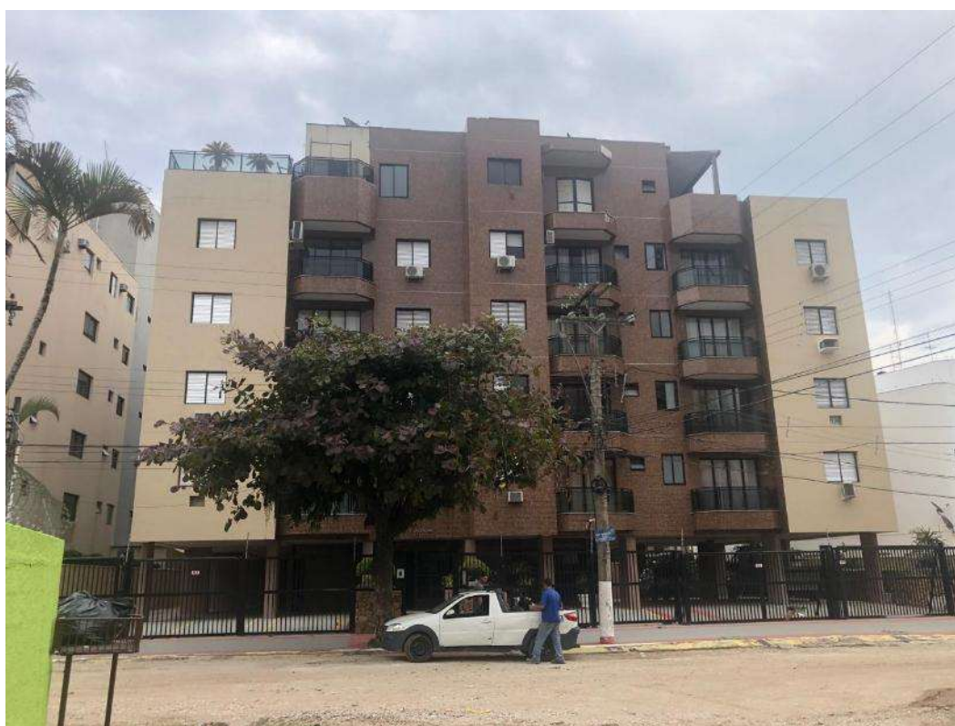
Figura 5 – Imagem do Edifício HERMON e sua localização; Rua Bandeirantes, nº68.
