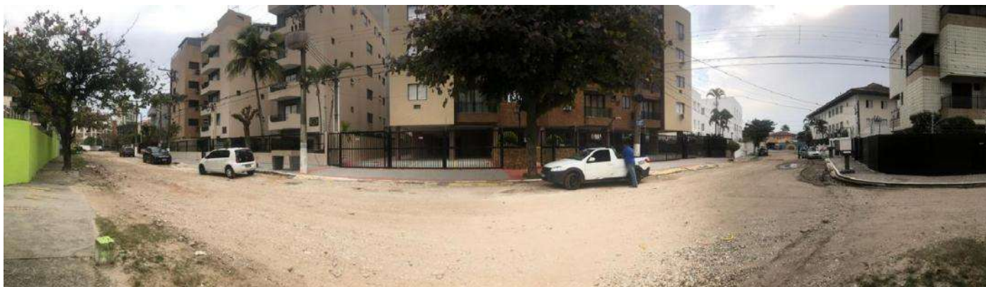
Figura 12 – Vista da extensão da Rua Amazonas e frente do Edifício avaliado.
