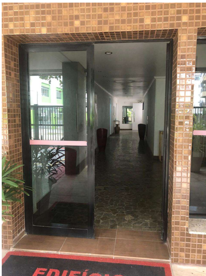
Figura 25 – Vista entrada do Edifício, hall de elevadores.
