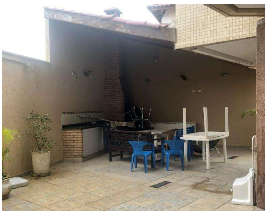
Figura 23 – Vista área de churrasqueira do Condomínio.
