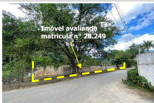
Foto 1. Vista para entrada do imóvel avaliando, objeto da Matrícula 28.249, situado em Pindamonhanagaba, SP.
