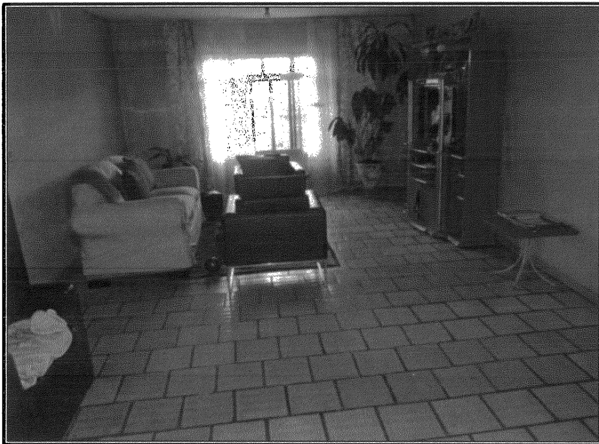
Vista parcial da sala, destacando o piso cerâmico, paredes com pintura à base de látex.
