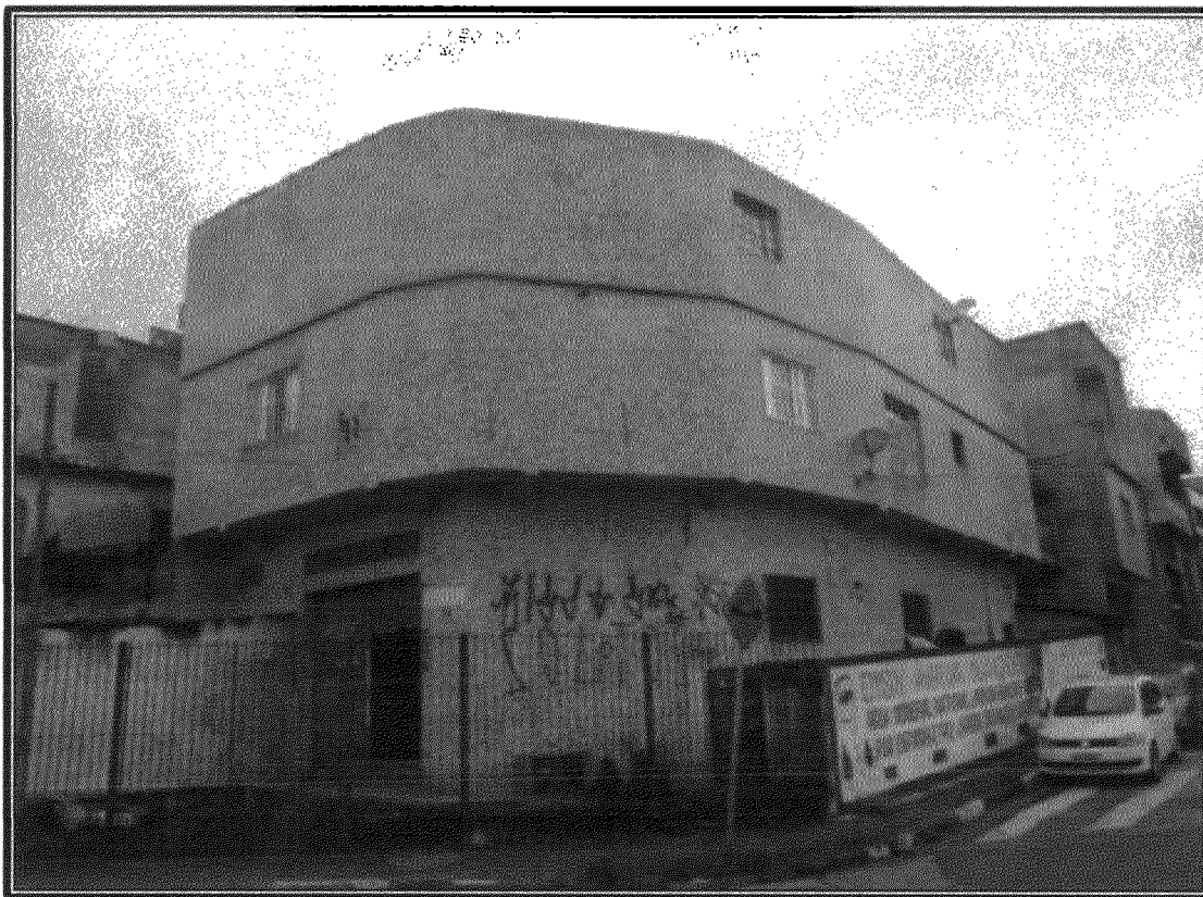
Fachada do imóvel avaliando, localizado na Rua Espanha nº202/206, esquina com Rua Inglaterra - Jd. Das Nações - Diadema - São Paulo.
