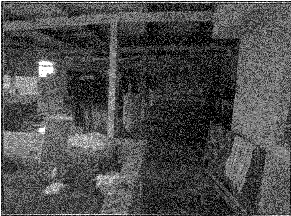
visão parcial do Galpão no segundo pavimento .
