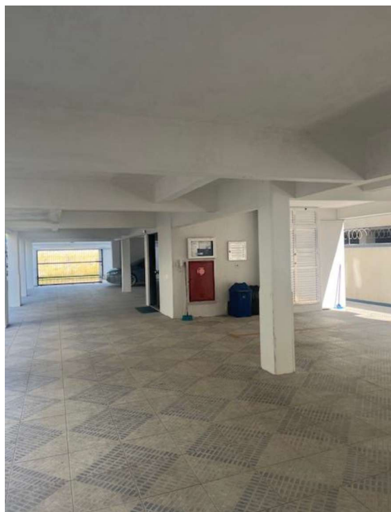
FOTO 10 – TÉRREO EM PILOTIS – VISTA DOS FUNDOS
