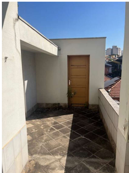
FOTO 16 – ÁREA EXTERNA COM PORTA DE ACESSO AO DORMITÓRIO EXTERNO AO FUNDO
