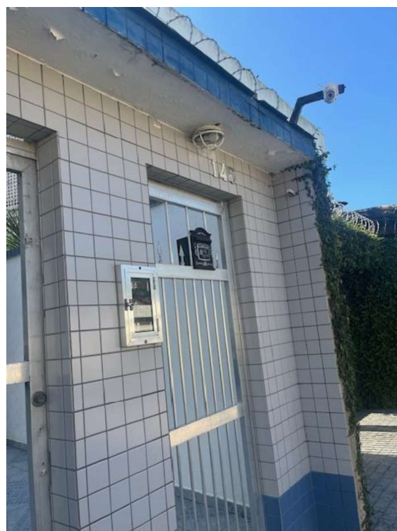
FOTO 07 – PORTÃO DE ACESSO DE PEDESTRE EDIFÍCIO FÁTIMA
