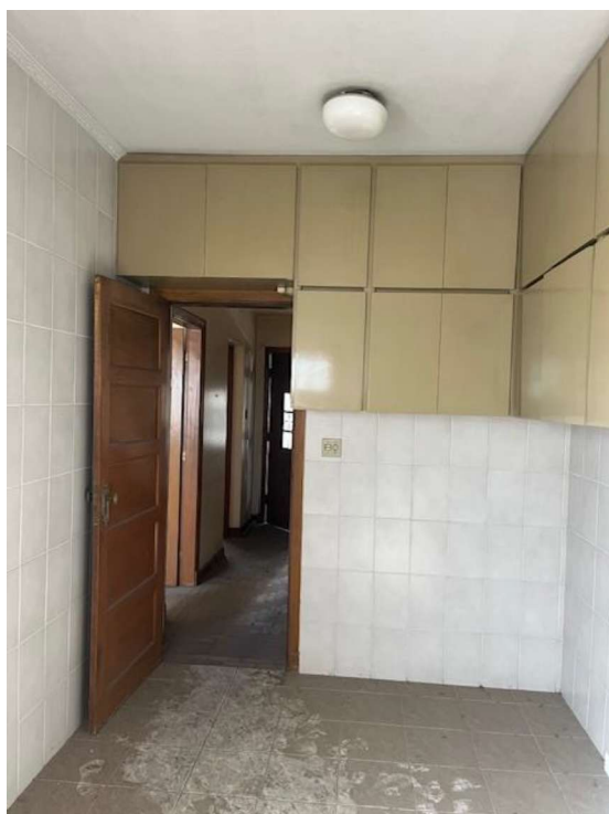
FOTO 15 – COZINHA COM HALL DE ENTRADA AO FUNDO
