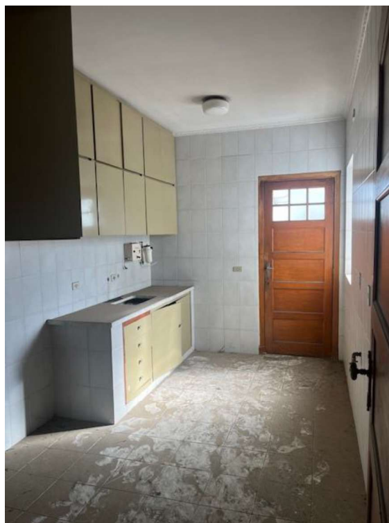
FOTO 14 – COZINHA COM PORTA DE ACESSO A ÁREA EXTERNA AO FUNDO
