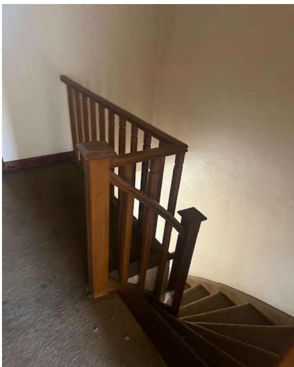
FOTO 21 – ESCADA DE ACESSO AO SEGUNDO PAVIMENTO
