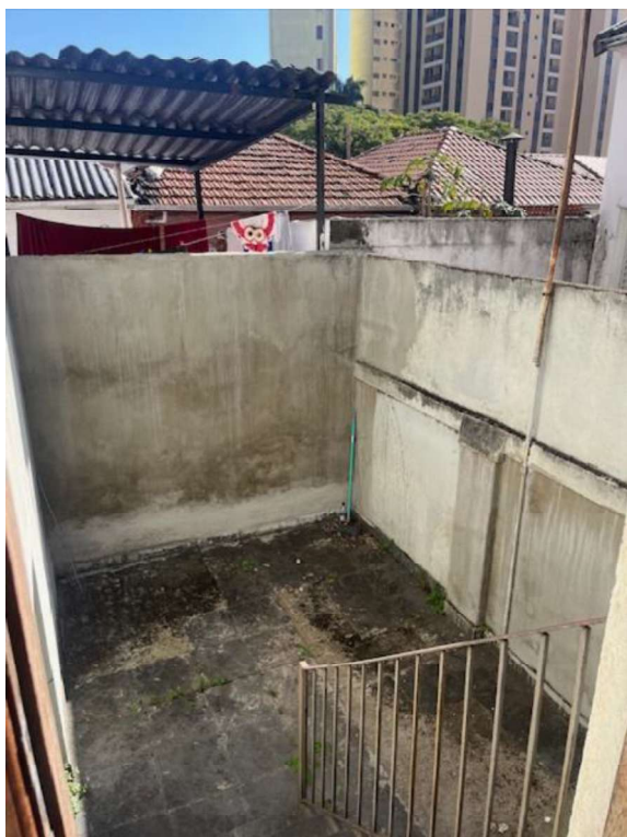
FOTO 37 – ÁREA EXTERNA COM ESCADA DE ACESSO
