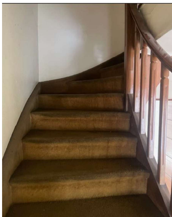
FOTO 20 – ESCADA DE ACESSO AO SEGUNDO PAVIMENTO
