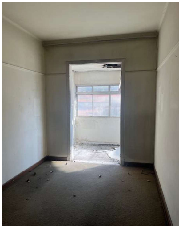
FOTO 22 – DOMITÓRIO 1 – SEGUNDO PAVIMENTO
