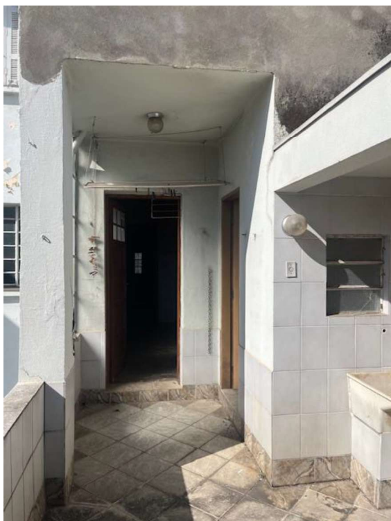
FOTO 17 – ÁREA EXTERNA COM PORTA DE ACESSO A COZINHA AO FUNDO E PORTA DE ACESSO AO BANHEIRO DO LADO DIREITO
