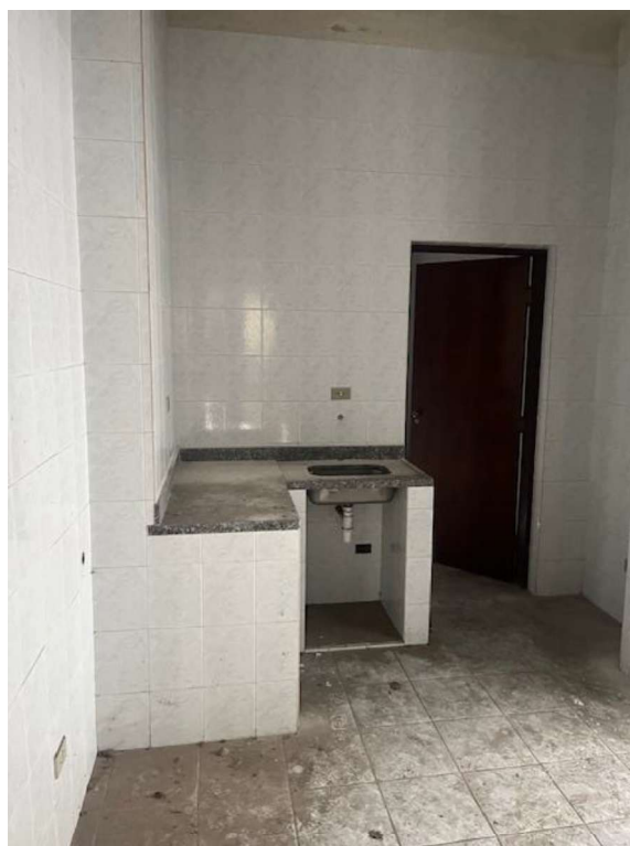
FOTO 34 – COZINHA COM PORTA DE ACESSO AO DORMITÓRIO 2 AO FUNDO
