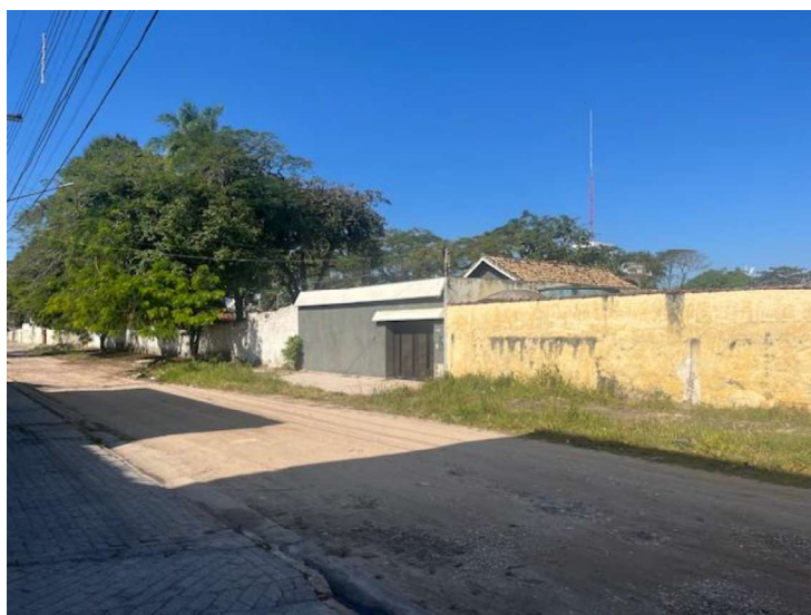
FOTO 03 – VISTA DA LATERAL ESQUERDA DO EDIFÍCIO FÁTIMA PELO TÉRREO
