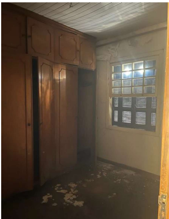
FOTO 27 – DOMITÓRIO 3 – SEGUNDO PAVIMENTO
