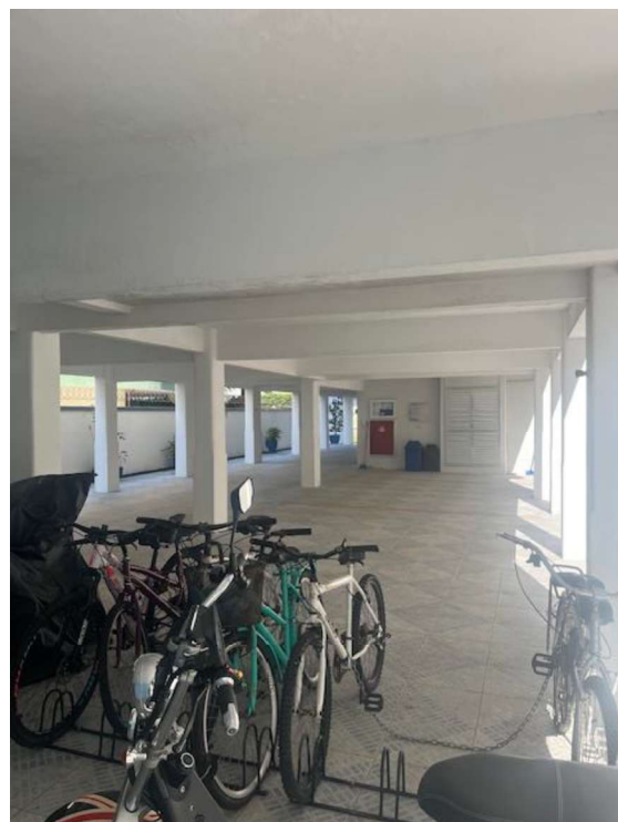
FOTO 11 – TÉRREO EM PILOTIS – VISTA DOS FUNDOS
