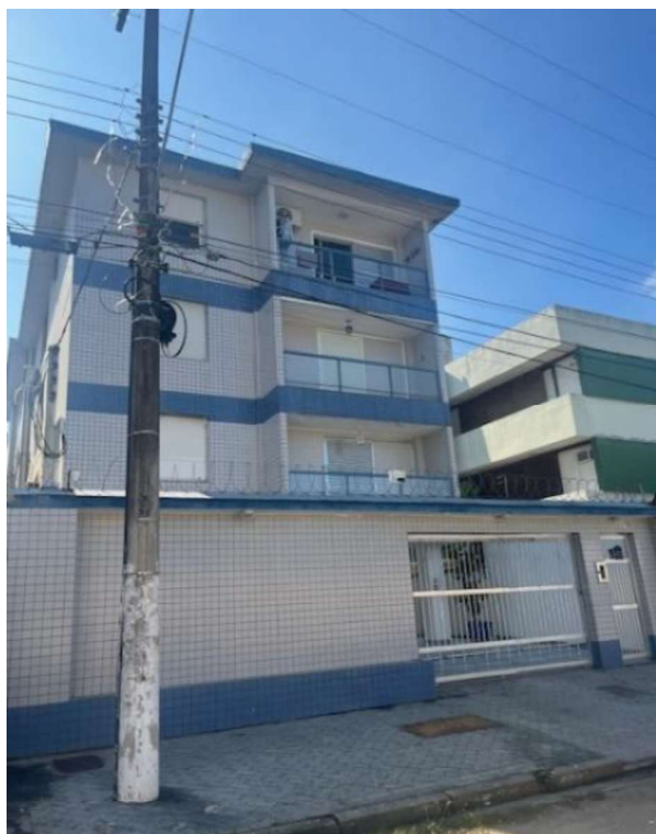
FOTO 04 – FACHADA PRINCIPAL DO EDIFÍCIO FÁTIMA
