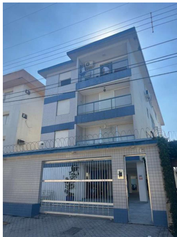
FOTO 05 – FACHADA PRINCIPAL DO EDIFÍCIO FÁTIMA
