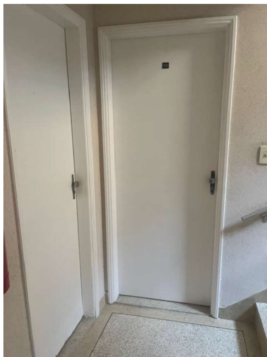
FOTO 17 – PORTAS DE ACESSO SOCIAL E SERVIÇO
