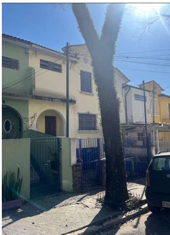
FOTO 07 – FACHADA PRINCIPAL DA CASA
