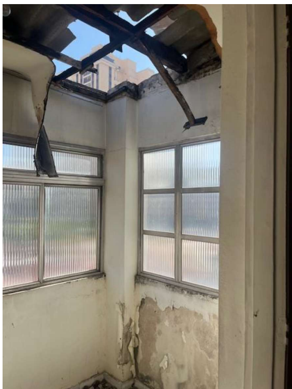
FOTO 25 – DOMITÓRIO 1– SEGUNDO PAVIMENTO
