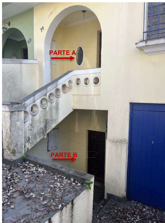
FOTO 08 – FACHADA COM ENTRADA PARTE A, ENTRADA PARTE B E PORTÃO GARAGEM
