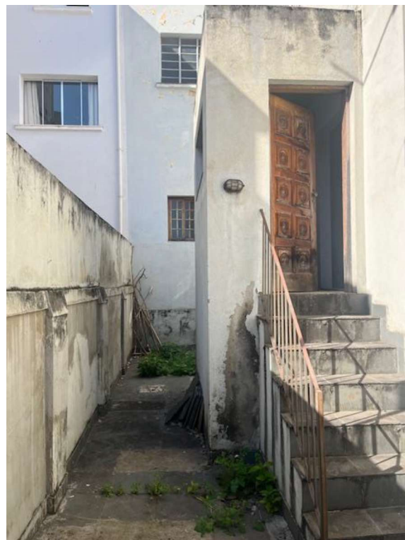
FOTO 38 – ÁREA EXTERNA COM PORTA DE ACESSO A COZINHA E CORREDOR DE ACESSO AO JARDIM A ESQUERDA
