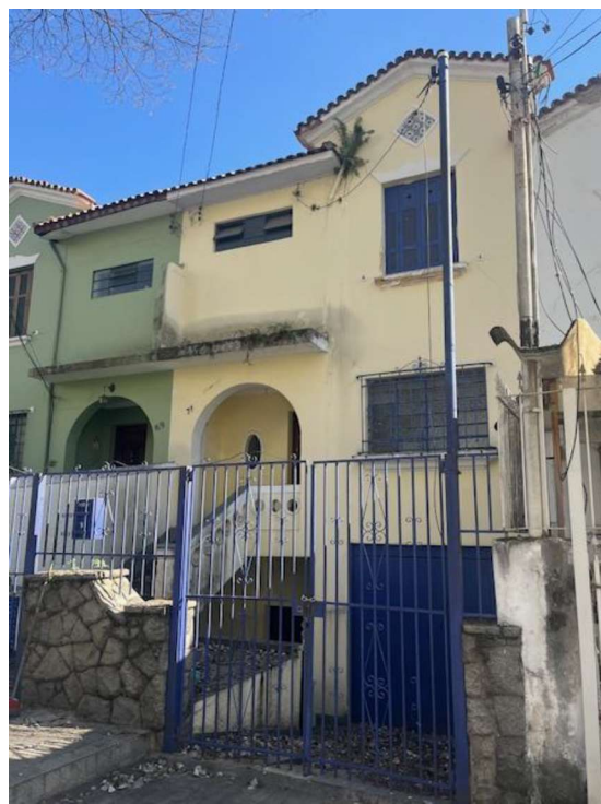
FOTO 06 – FACHADA PRINCIPAL DA CASA
