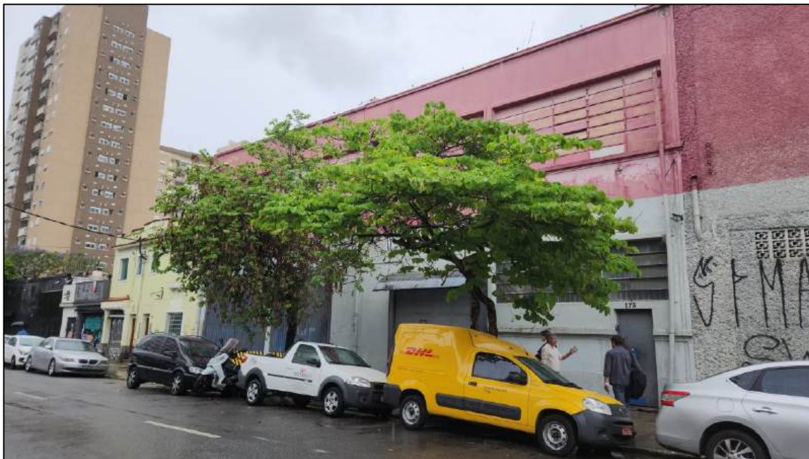
Foto 01 – Fachada/ frente do imóvel pela Rua Roma
