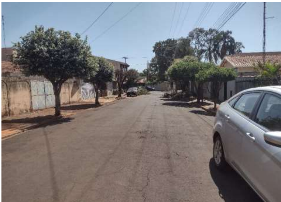
Rua Carlos de Campos – Vista sentido a Rua Augusto Figueiredo
