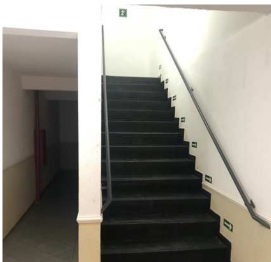
Imagem 13: Escadas de acesso a pisos superiores
