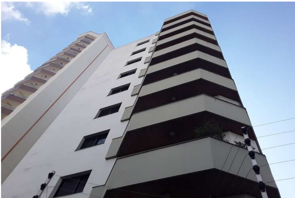
FOTO nº 08 Mais uma vista da fachada frontal do Edifício Maison Royale.
