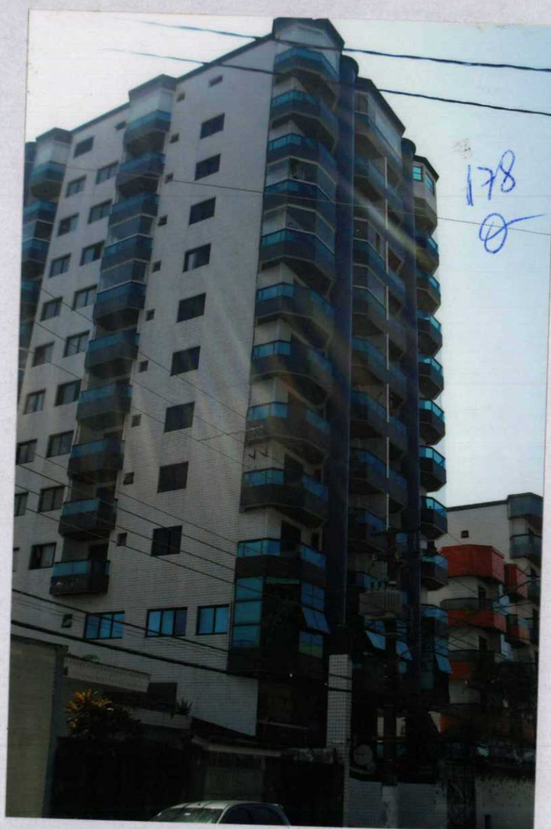
Foto nº 0 fachada do Condomínio Edifício DÉBORA , do apartamento nº 12 avaliando, frente para Rua Argentina
