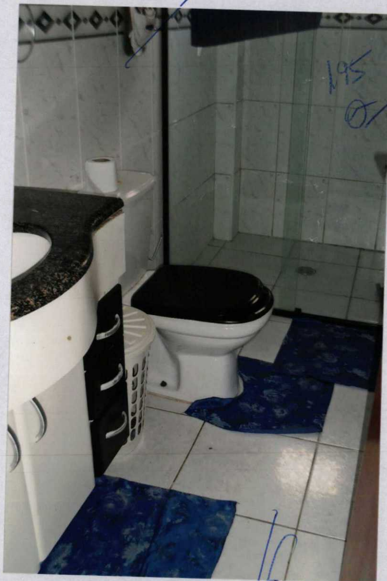
foto nº 18 - banheiro da suite com piso e parede de porcelanato, louça sanitária de boa qualidade, com lavatório com tampo de granito e gabinete de madeira, box blindex.
