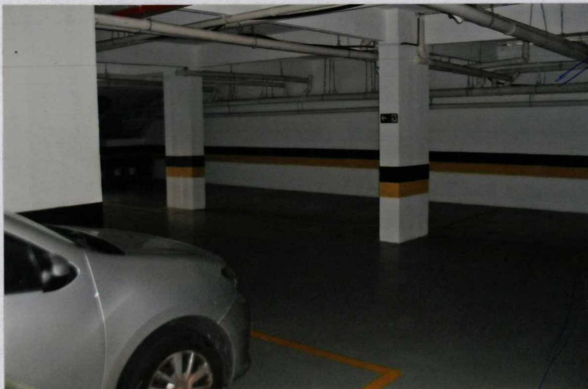
Foto nº 5 - Detalhe da garagem coletiva no subsolo
