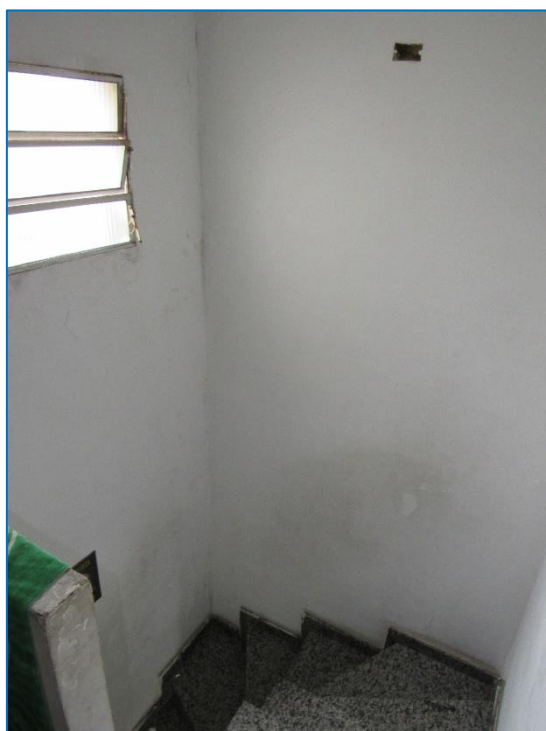
Outra vista da escada de acesso.
