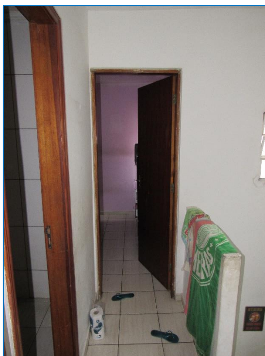
Outra vista da circulação.
