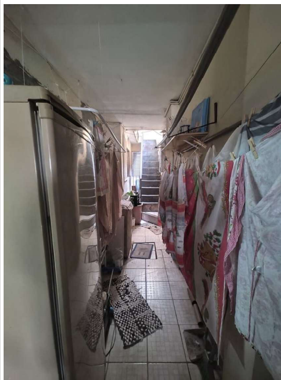
Corredor lateral e escada para acesso a piso intermediário
