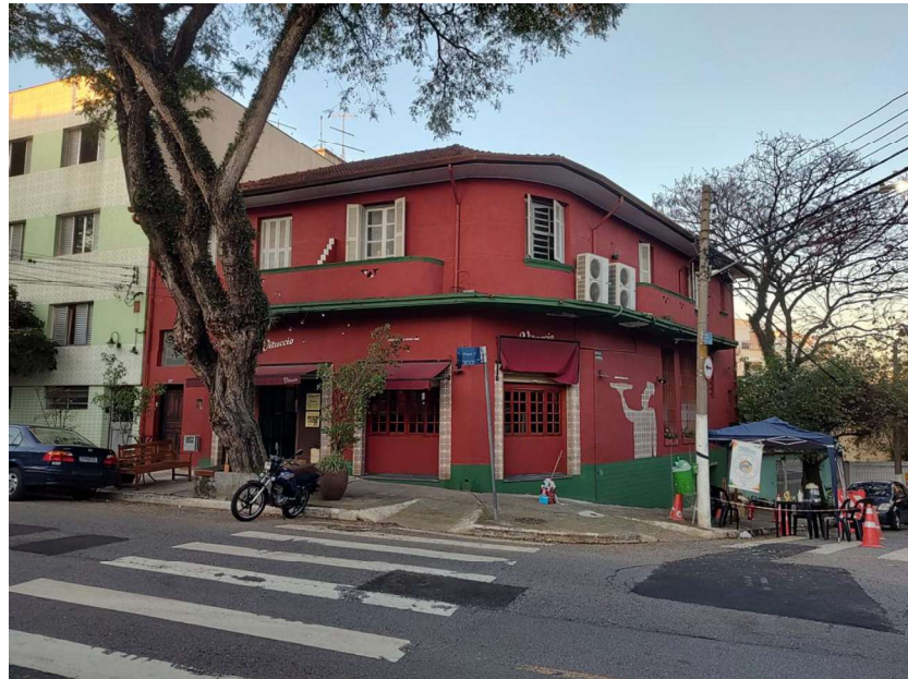
Vista da fachada em esquina do imóvel
