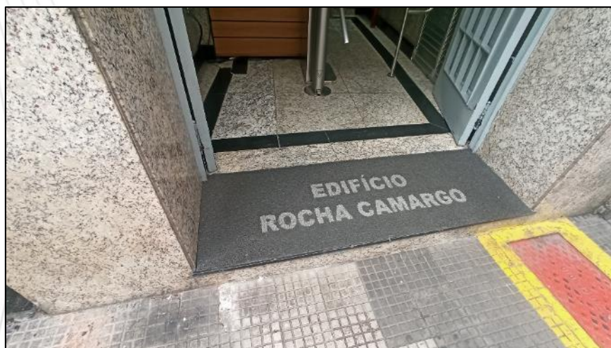
Foto 48. Entrada do Edifício
