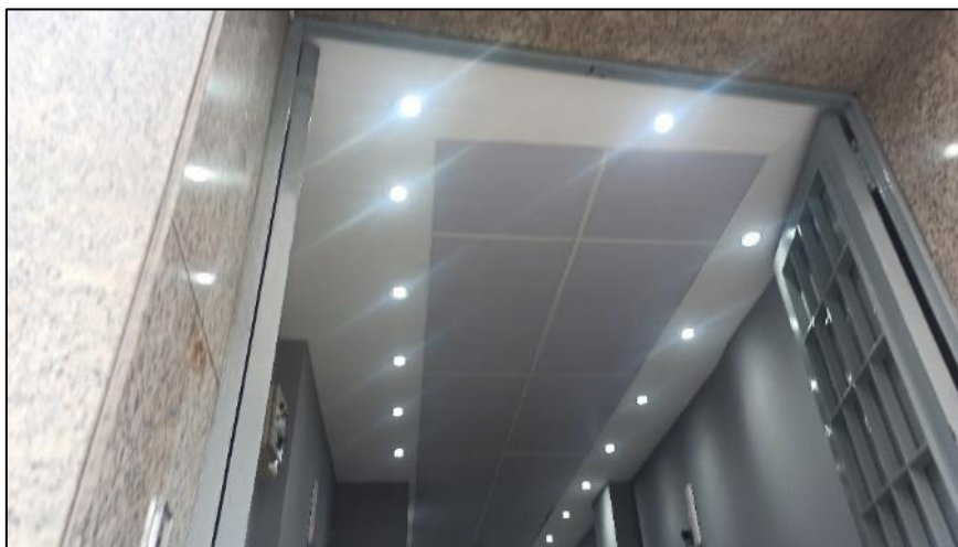
Foto 46. Entrada do Edifício
