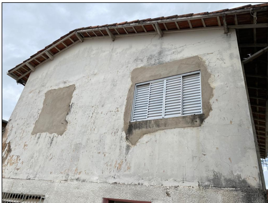
Foto 9 – Vista geral da parte dos fundos da casa, observando-se seu padrão construtivo e estado de conservação.
