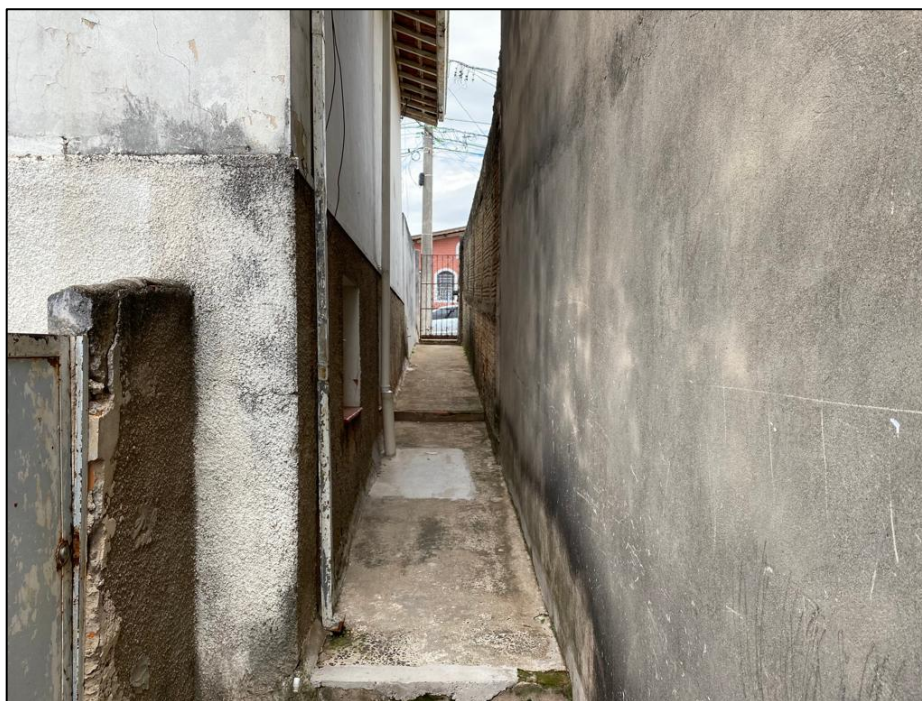
Foto 7 – Vista geral do quintal lateral da casa, observando-se seu padrão construtivo e estado de conservação.
