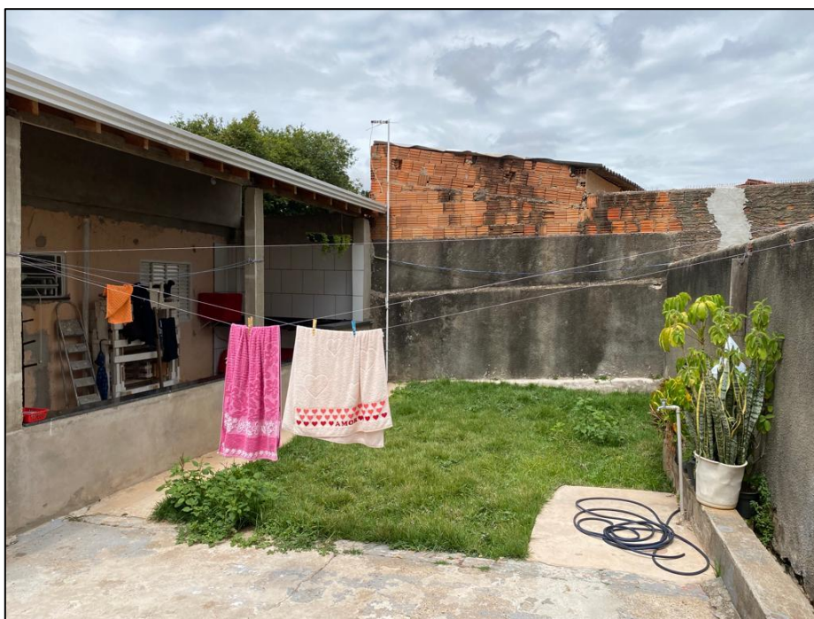
Foto 15 – Outra vista geral da varanda da edícula, observando-se seu padrão construtivo e estado de conservação.
