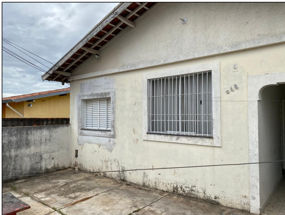
Foto 5 – Outra Vista geral da garagem do imóvel avaliando, observando-se seu padrão construtivo e estado de conservação.
