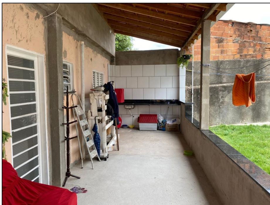
Foto 14 – Vista geral da varanda da edícula, observando-se seu padrão construtivo e estado de conservação.
