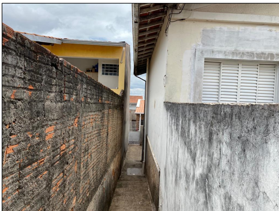
Foto 8 – Outra vista geral do quintal lateral da casa, observando-se seu padrão construtivo e estado de conservação.
