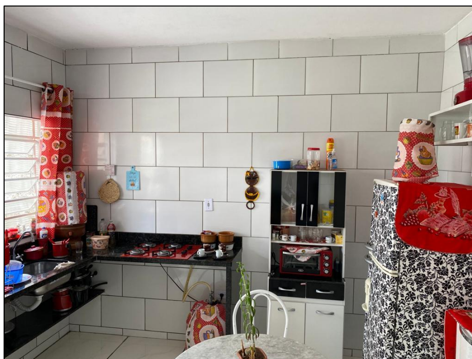
Foto 18 – Outra vista geral da cozinha da edícula, observando-se seu padrão construtivo e estado de conservação.
