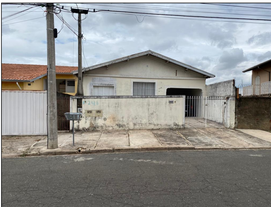
Foto 3 – Vista geral do imóvel avaliando, localizado na Rua Almirante Custódio José de Melo, nº 246, Jardim Novo Campos Elíseos, Campinas – SP.
