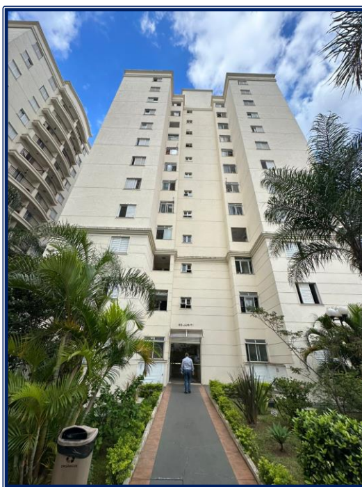
Vista panorâmica do Edifício Juriti
