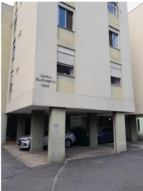
Fachada Bloco A
