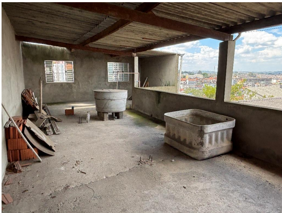
Foto 26 – cobertura no piso superior
