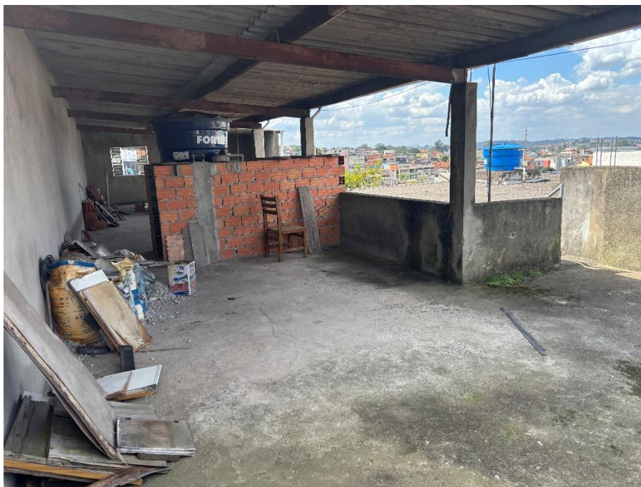
Foto 25 – cobertura no piso superior
