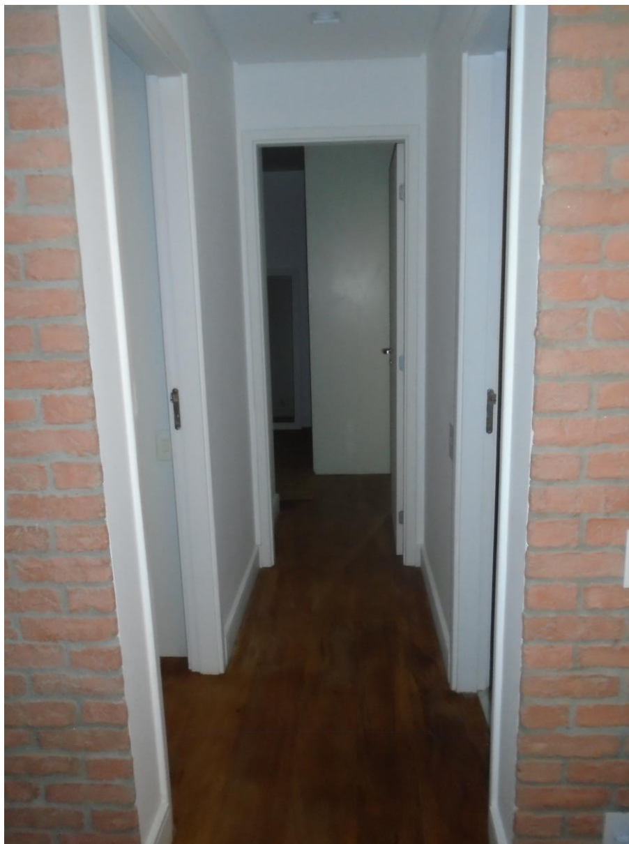
FOTO 31 – ASPECTO HALL DE CIRCULAÇÃO.
