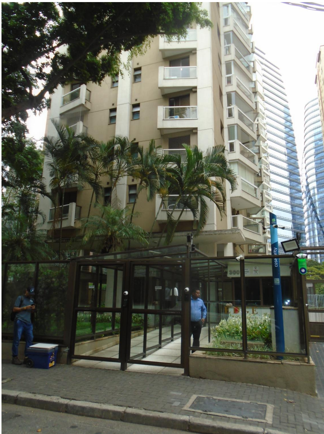
FOTO 04 – FACHADA FRONTAL e ENTRADA SOCIAL ED. FUNCHAL DO COND.EDGE.
