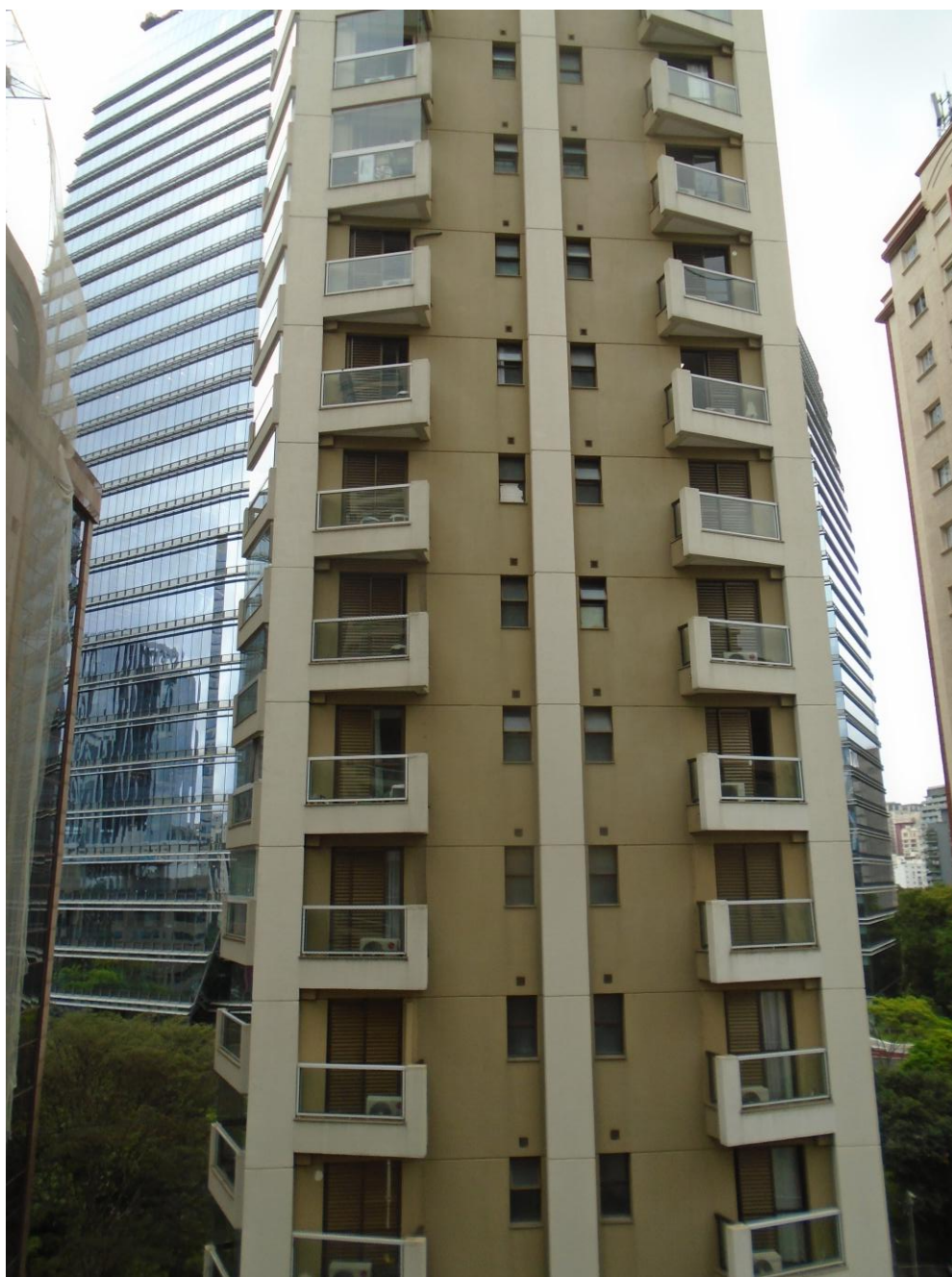
FOTO 35 – VISTA DA FACHADA DA 2ª. TORRE ED. FUNCHAL.
