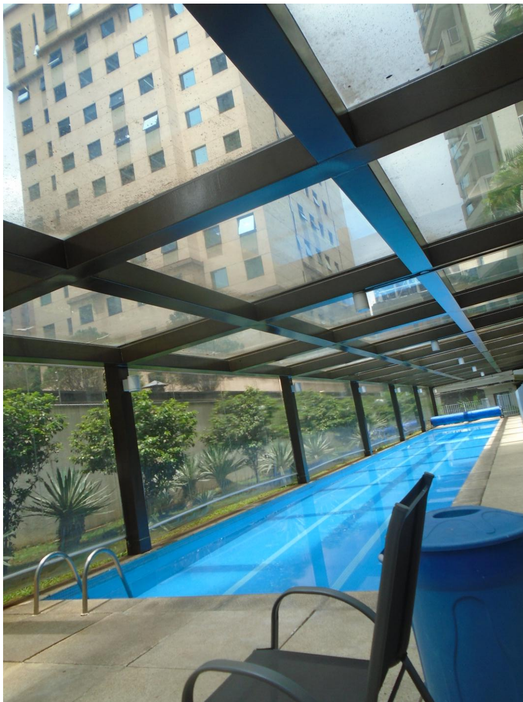
FOTO 16 – COBERTURA EM PLACAS DE VIDRO NA ÁREA DA RAIA DA PISCINA.
