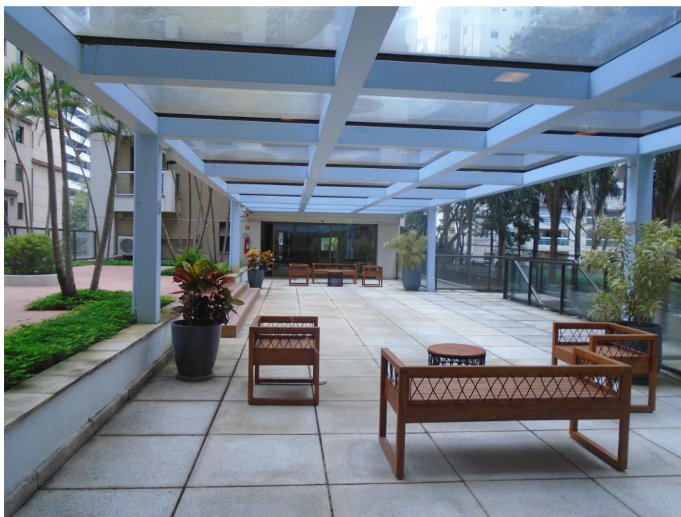
FOTO 12 – COBERTURA INSTALADA ENTRE OS DOIS BLOCOS NO TÉRREO.
