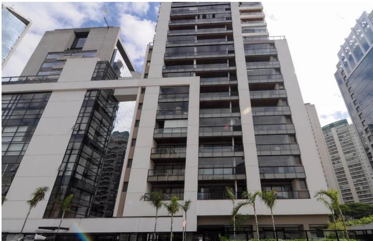
EDIFICIO LIMITED FUNCHAL - RUA FUNCHAL 449.
