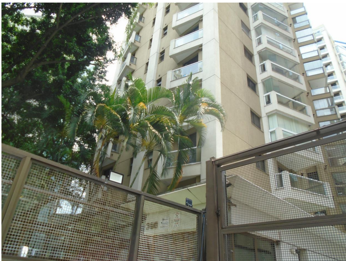
FOTO 05 – FACHADAS COM VARANDAS PROJETADAS NA SALA E DORMITÓRIO.
