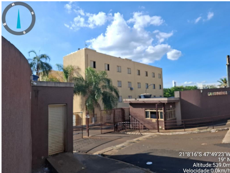
Foto 3 - Vista da fachada do condomínio
