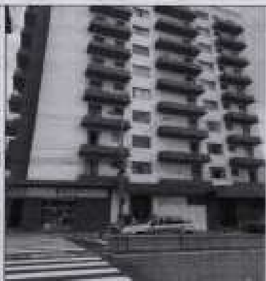
Foto – Frente do prédio
