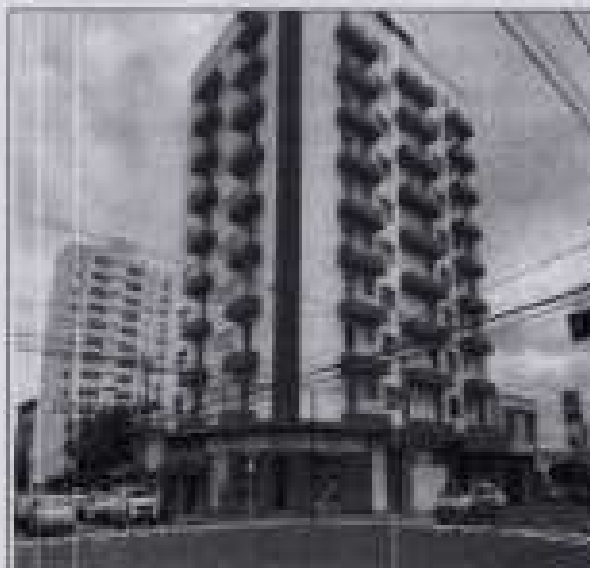
Foto – Fachada para Av. Rodrigues Alves e Rua Antonio Alves
